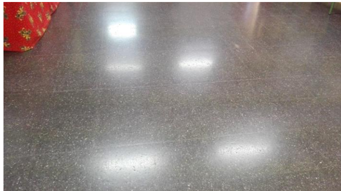
Imagen 7. Detalle del suelo interior.
