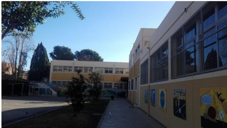
Imagen 3. Fachada principal del edificio.
