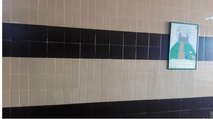
Imagen 6. Detalle de la pared interior.
