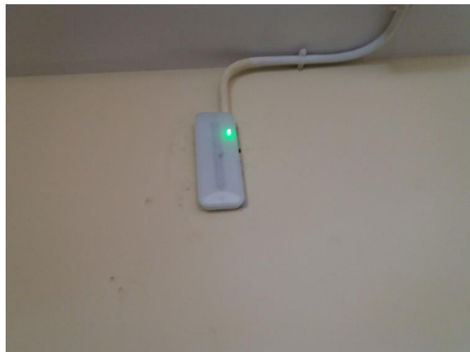
Imagen 18. Luminaria de emergencia.
