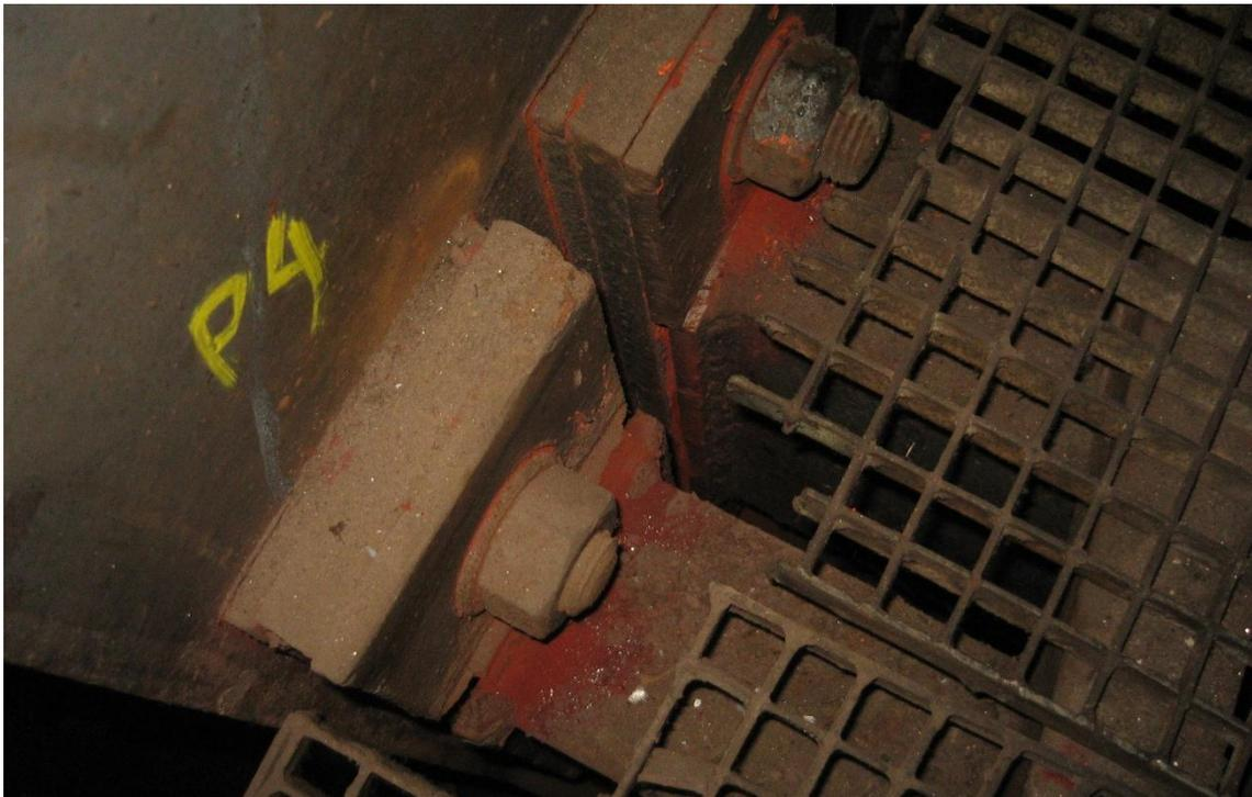
Imagen 11. Rotura de la placa de unión del soporte al pilar principal a lo largo del cordón de soldadura.
