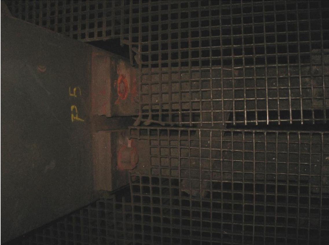
Imagen 12. Rotura del perno superior que une la placa del soporte con el pilar principal de la nave.
