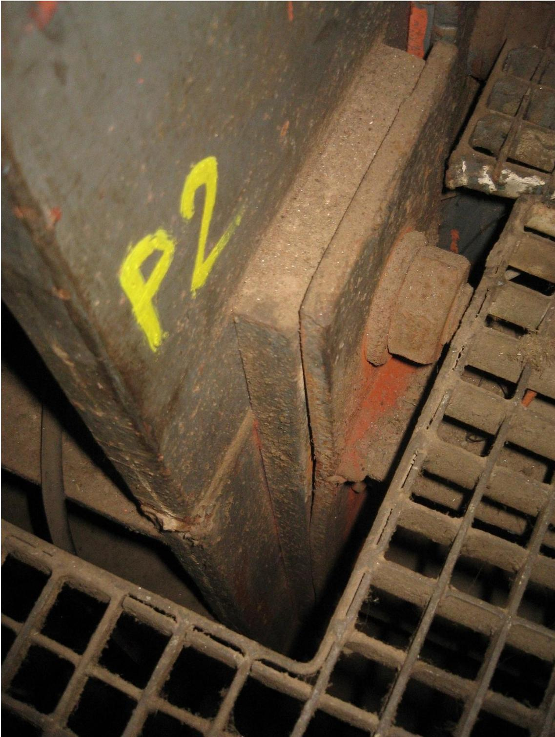
Imagen 14. Deformación plástica de la chapa de unión del soporte con el pilar principal.
