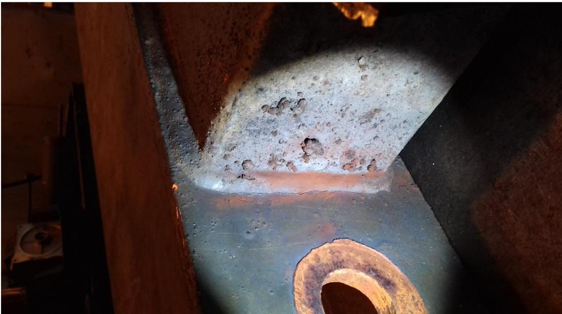
Imagen 13. Inicio de grieta en soldadura de unión entre la UPN-300 y la placa de anclaje del soporte.
