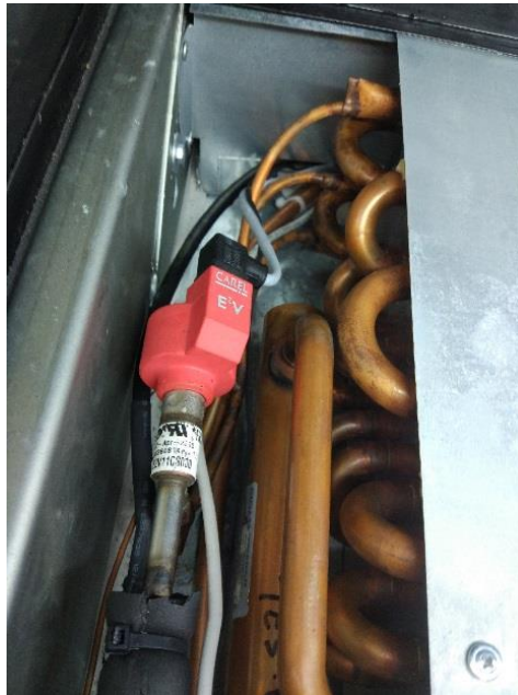
Figura 33. Válvula de expansión electrónica.
