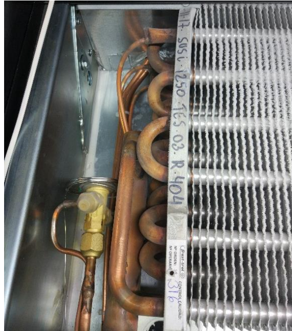
Figura 31. Foto de la válvula de expansión termostática.
