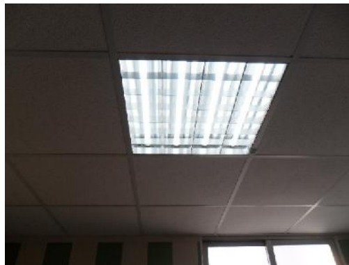
Imagen 8. Luminaria formada por 4 tubos T8 de 18 W y 0,60 metros de longitud cada uno.
