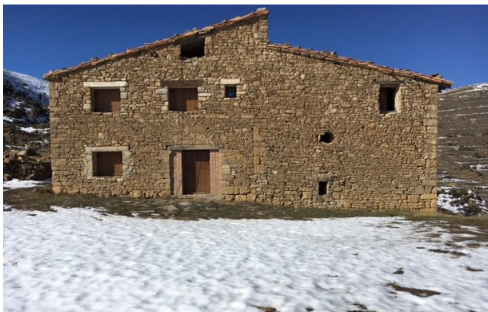
Ilustración 4. Era y fachada de la Masía Torre Algares (Edificio proyectado)
