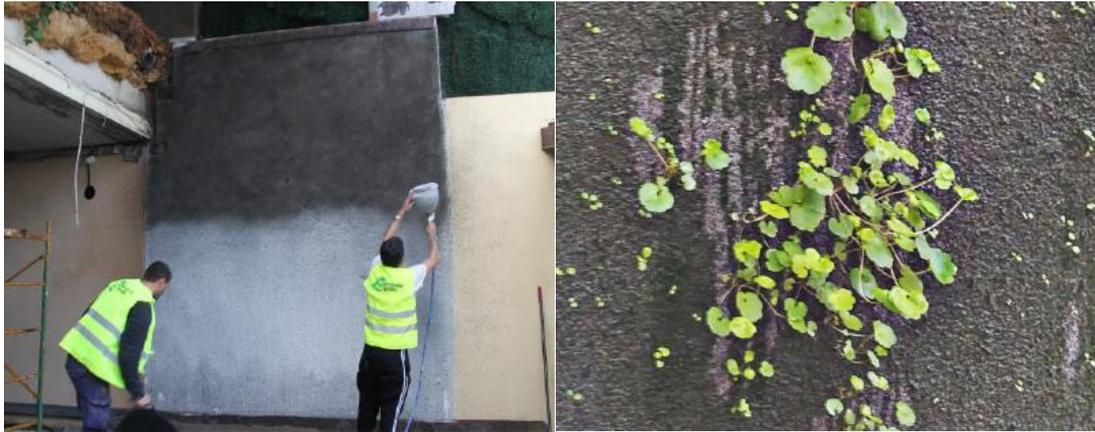
49. Proyección Sustrato L+S Ecoactive sobre Membrana de adherencia L+S Root y posterior germinación
