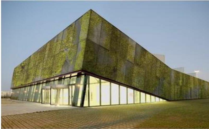
*48. Edificio Acabado mediante Hormigón Vegetal*
