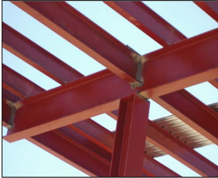
Figura 23: Unión mediante soldadura
