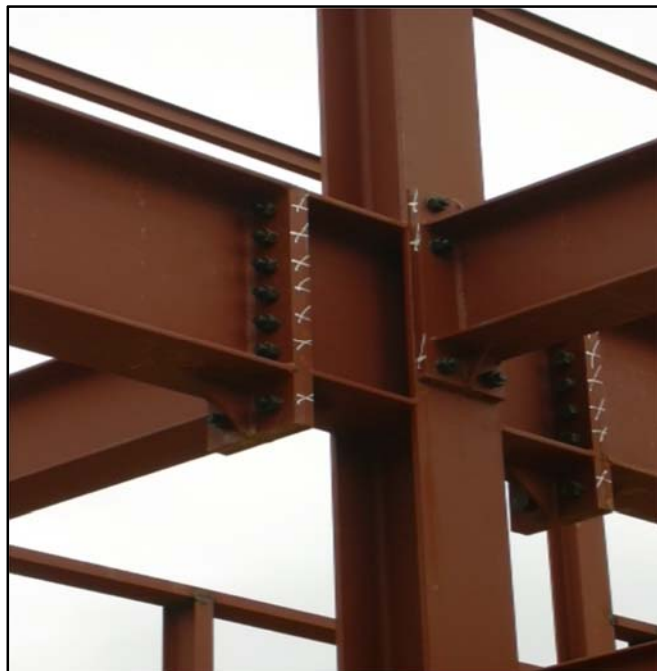
Figura 24: Unión mediante tornillos
