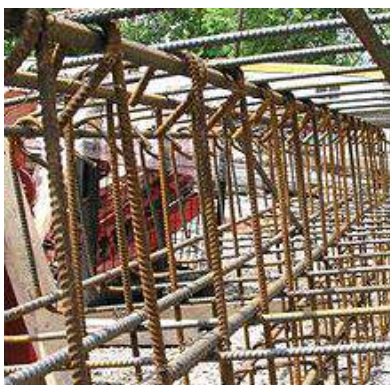
Fig. 3.2.3.1. Tabla propiedades acero B500S y foto representativa del acero para armadura.
