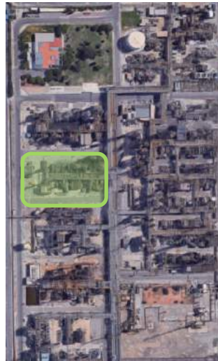
Fig. 1.3.1. Vista aérea de la planta e indicación de la unidad de vacío.
