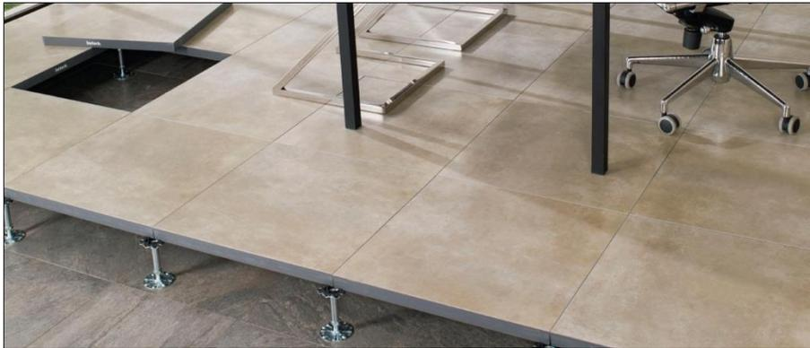
Figura 22. Imágenes de suelo técnico ya instalado.
