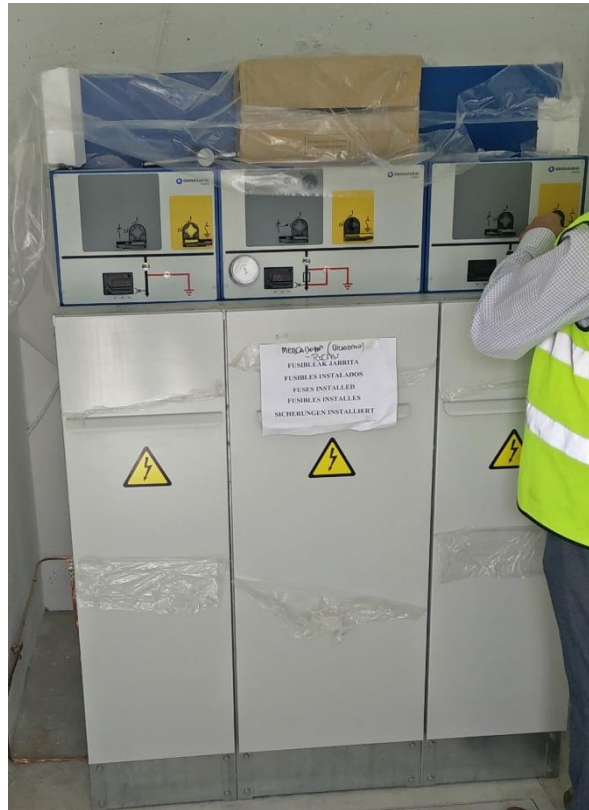
Imagen 12. Celdas de centro de seccionamiento en edificio de otros usos ubicado en la calle senda pescadors de Villa-Real.
