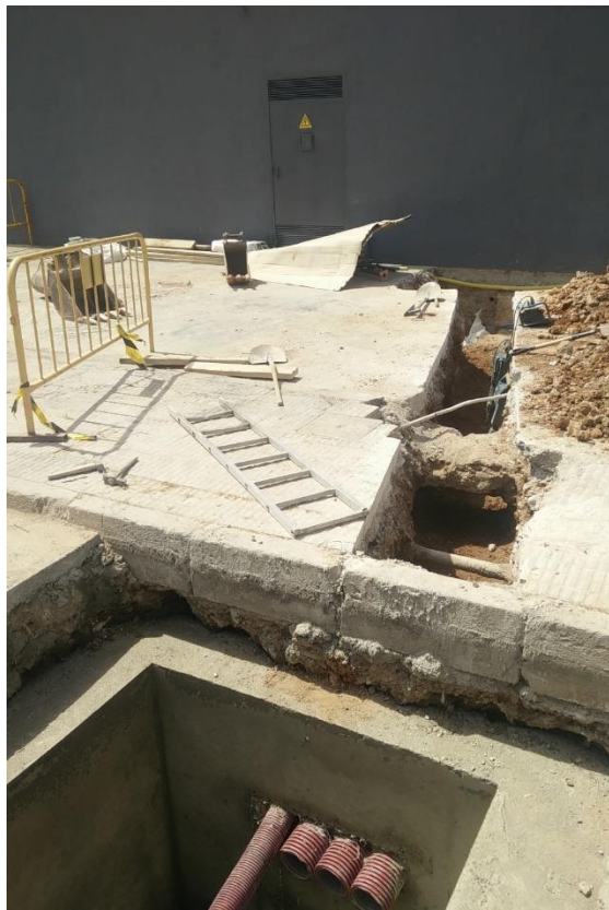
Imagen 8. Zanja, arqueta y tubos ya instalados en la calle senda pescadors de Villa Real, en la zanja se pueden apreciar los cruzamientos con una tubería de gas de baja presión
