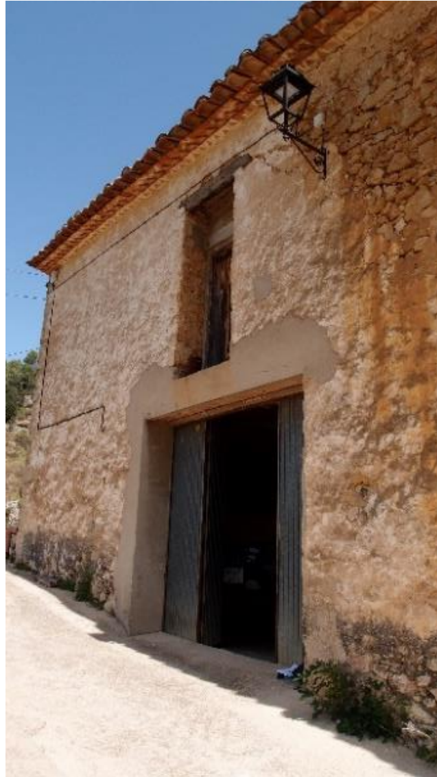
Fachada sudoeste. Acceso al garaje
