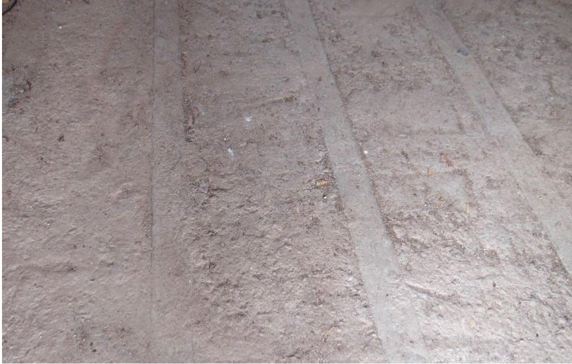
Imagen: Cara superior del forjado en primera planta
