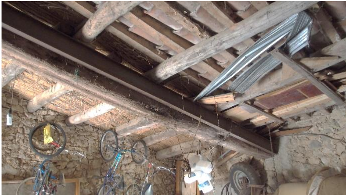
Estructura de cubierta
