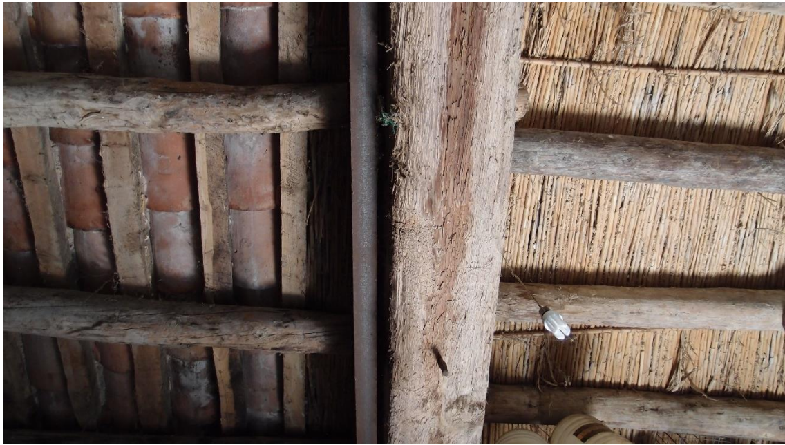
Imagen: Estructura de cubierta
