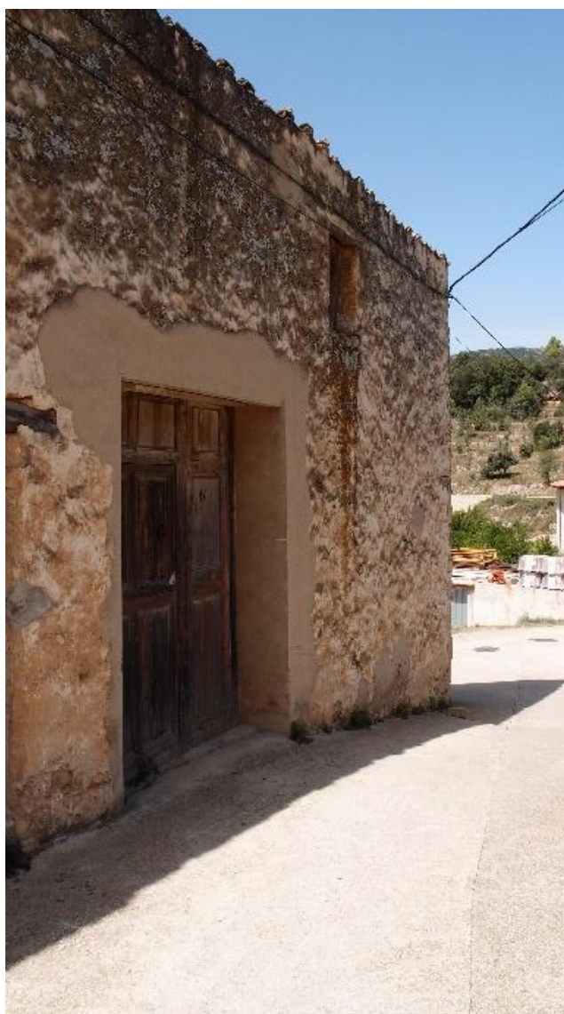
Fachada nordeste (Acceso almacén)
