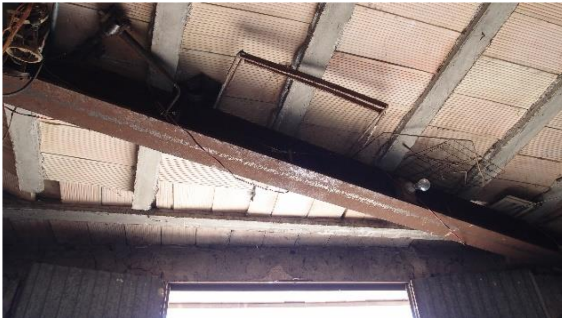
Viga de apoyo viguetas en forjado
