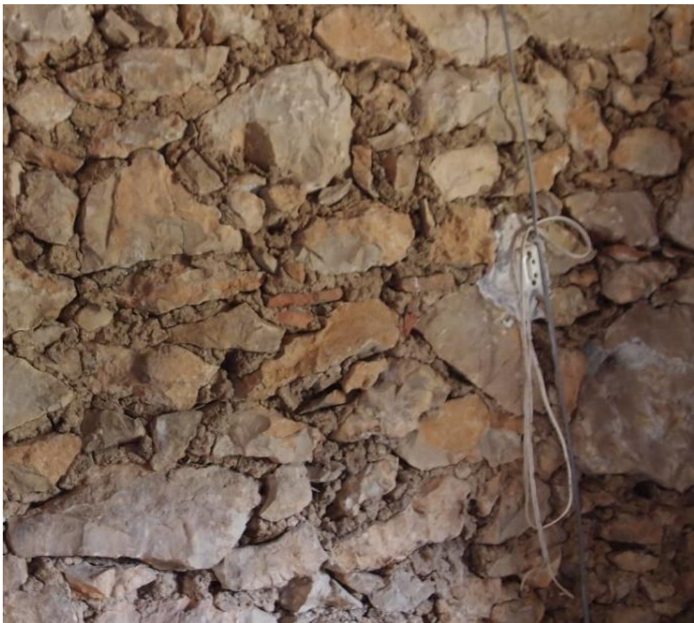
Imagen: Interior muros
