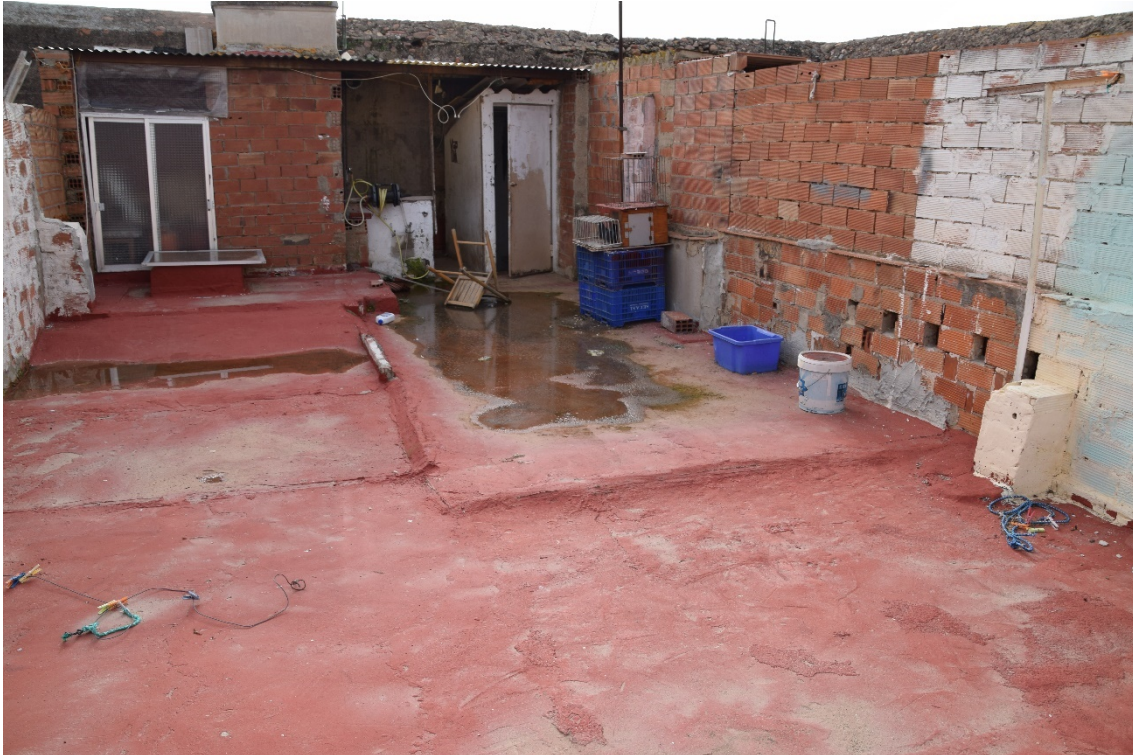
Figura 94. Vista de la cubierta plana, al fondo la parte techada y el acceso. Fuente: Propia.
