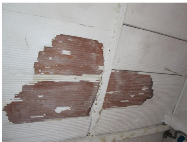
Figura 56. Vista del techo del baño. Fuente: Propia.
