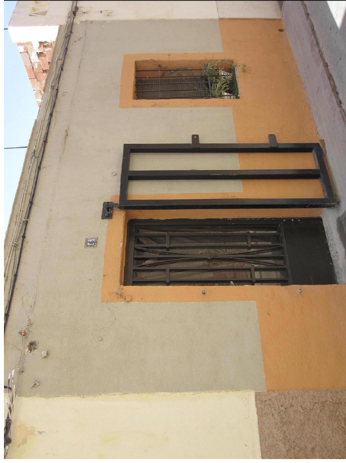
Fotografía de la fachada principal
