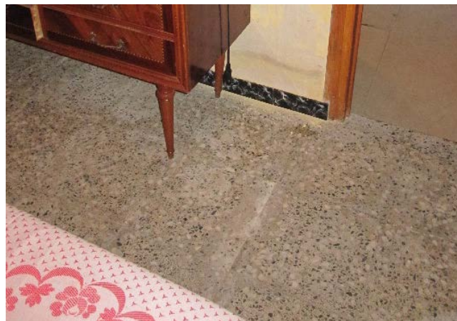
Figura 67. Pavimento de uno de los dormitorios. Fuente: Propia.
