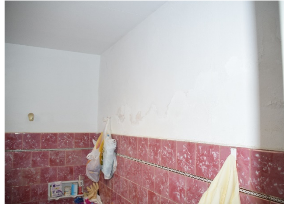
Figura 79. Alicatado del baño. Fuente: Propia.
