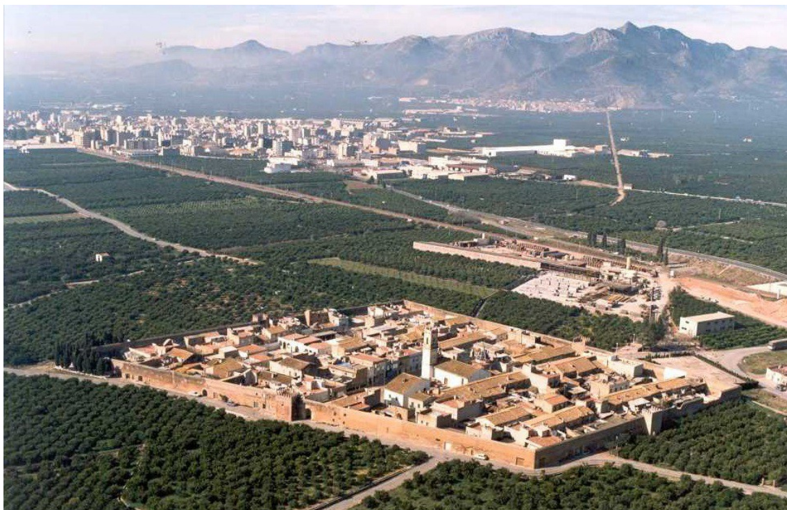
Figura 2. Vista aérea de Mascarell. Fuente: valenciabonita.es
