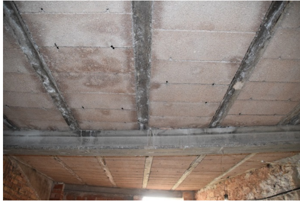
Figura 74. Forjado del garaje. Fuente: Propia.
