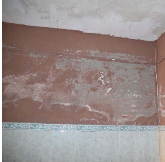
Figura 98. Revestimiento de las paredes en el salón. Fuente: Propia
