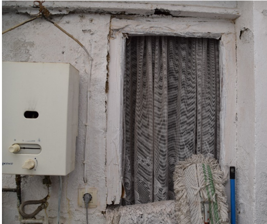
Figura 121. Ventana del baño al patio. Fuente: Propia.
