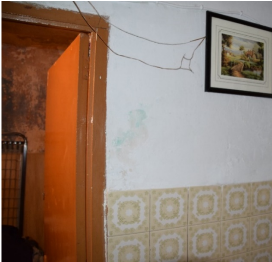
Figura 113. Revestimientos de la zona de paso. Fuente: Propia.
