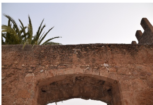
Figura 6. Arco rebajado del intradós del portal de Valencia. Fuente: Propia
