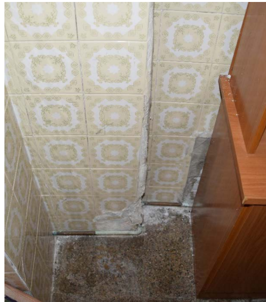
Figura 124. Suministro del AFCH, a su paso por el salón. Fuente: Propia.
