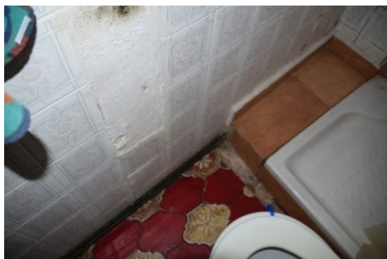
Figura 129. Equipamiento del baño, donde se puede apreciar la estrechez de este y como tienen que estar dispuestos los aparatos. Fuente: Propia.
