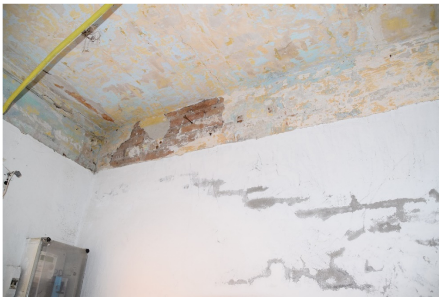
Figura 90. Detalle del muro donde se aprecia su composición. Fuente Propia.
