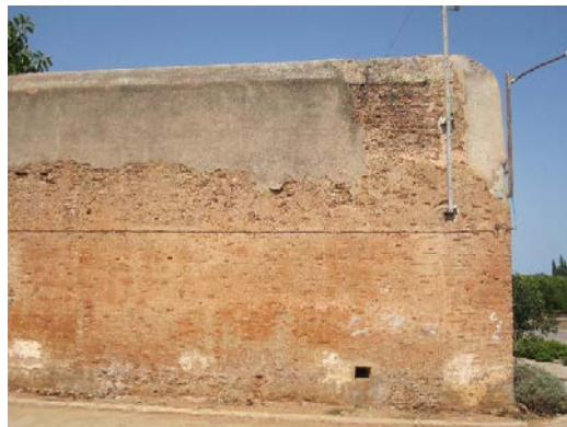
Figura 14. Esquina Sureste, al igual que en otros puntos de la muralla se puede ver los añadidos realizados sin respetar la tapia original Fuente: Propia
