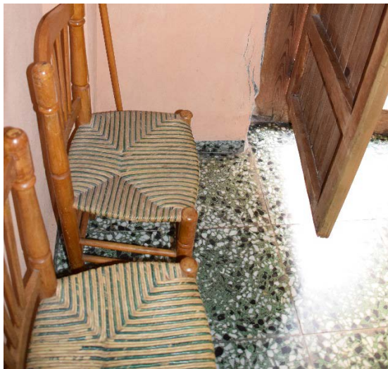
Figura 80. Pavimento del recibidor. Fuente: Propia.
