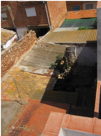
Figura 59. Cubierta del cobertizo. Fuente: Propia.
