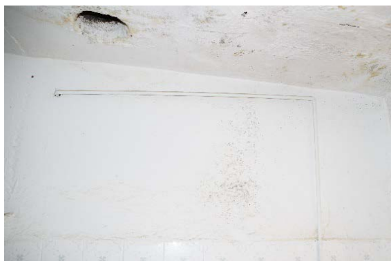
Figura 127. Salida de humos de la cocina. Fuente: Propia.
