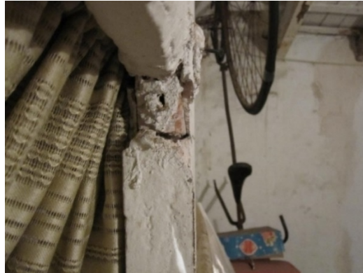
Figura 64. Detalle del tabique. Fuente: Propia.
