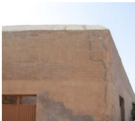
Figura 13. Esquina Norte-Este, rehabilitada a partir de un encofrado perdido de ladrillos. Fuente: Propia
