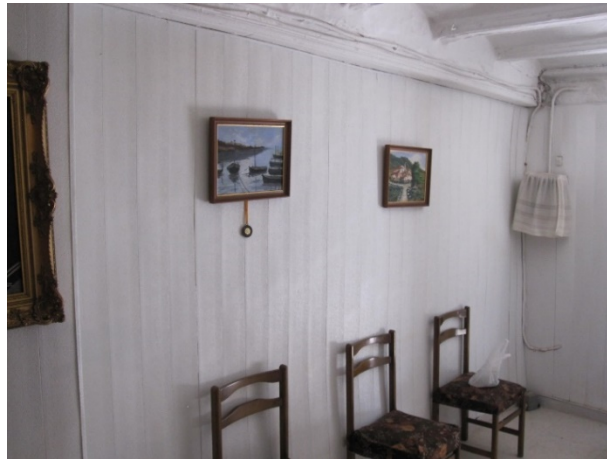
Figura 66. Recubrimiento de láminas de plástico. Fuente: Propia.
