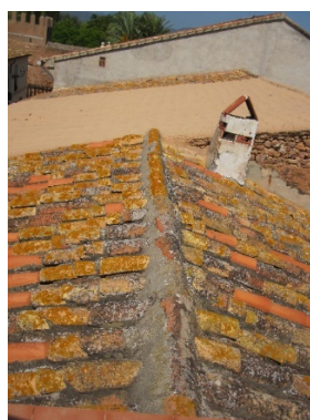
Figura 58. Vista cubierta a dos aguas. Fuente: Propia.
