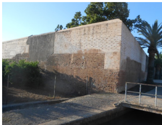
Figura 26. Esquina Norte-Oeste reconstruida. Fuente: Propia.
