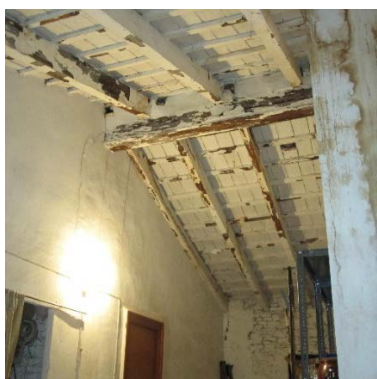
Figura 57. Vista bajo cubierta. Fuente: Propia.
