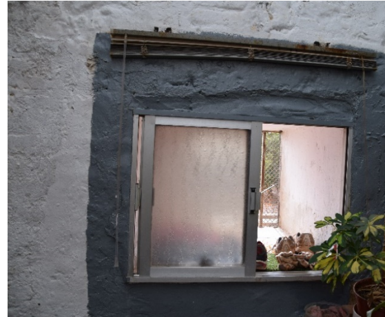
Figura 122. Ventana en la muralla. Fuente: Propia.
