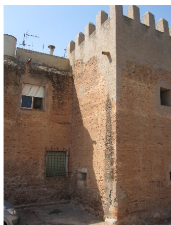
Figura 17 y Figura 18. Estado actual tras la desacertar intervención, realizada mediante ladrillo enfoscado, de los revellines Este y Sur respectivamente. Fuente: Propia.
