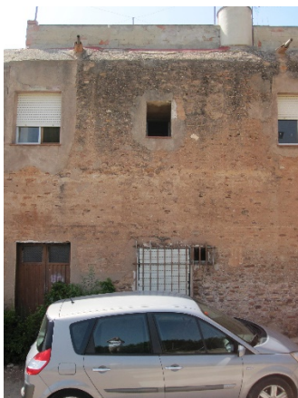
Figura 134. Elementos impropios de la muralla. Fuente Propia.
