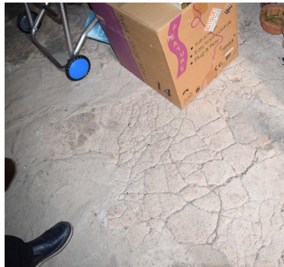
Figura 81. Suelo del almacén en la planta superior. Fuente: Propia.
