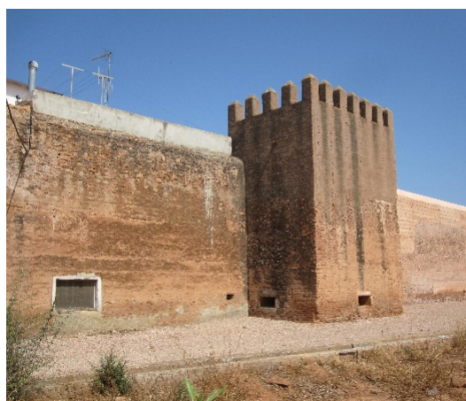
Figura 17 y Figura 18. Estado actual tras la desacertar intervención, realizada mediante ladrillo enfoscado, de los revellines Este y Sur respectivamente. Fuente: Propia.
