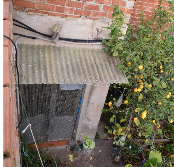
Figura 83. Las zonas de paso en el patio cuentan con una solera de hormigón. Fuente: Propia.
