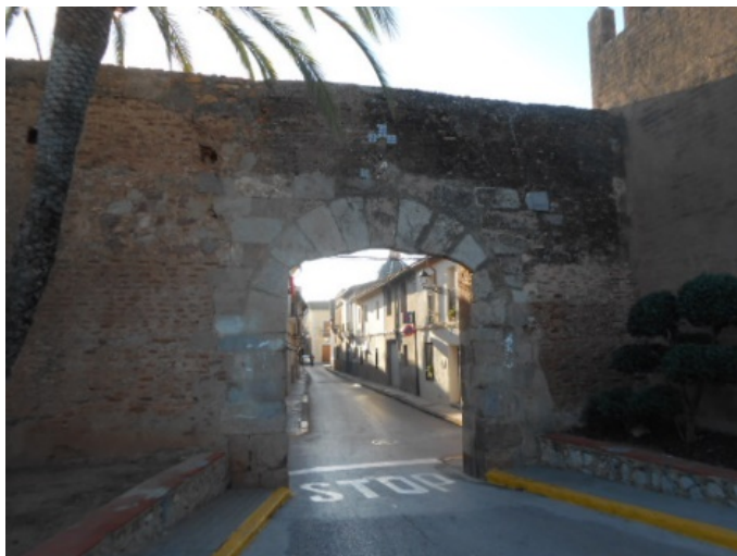
Figura 7. Portal de Valencia, donde se ve la mutilación de las dovelas. Fuente: Propia
