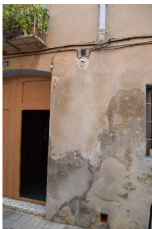
Figura 76. Vista de la fachada principal. Fuente: Propia.
