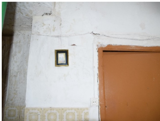
Figura 126. Muestra de la instalación eléctrica de la vivienda. Fuente: Propia.
