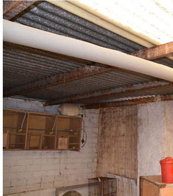
Figura 92. Zona techada de la parte superior. Fuente: Propia.
