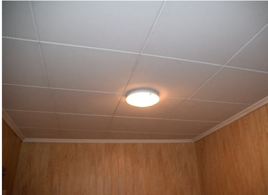
Figura 78. Cubrimiento de las paredes y el falso echo en un dormitorio. Fuente Propia.
