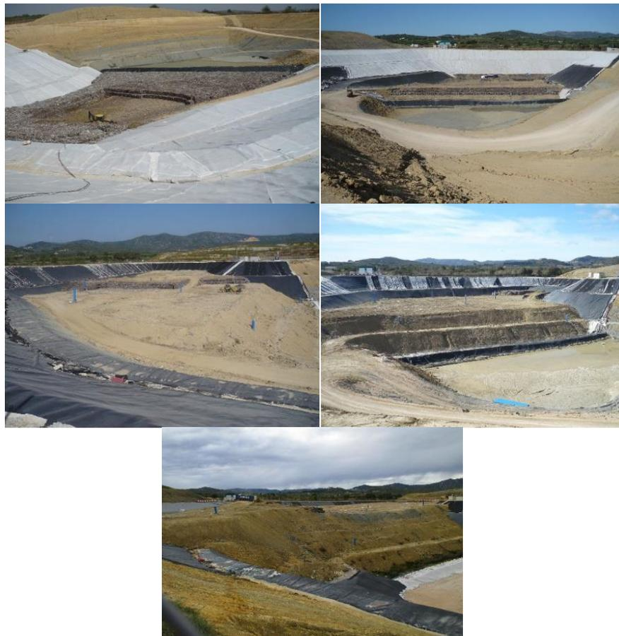
Una vez se terminó de llenar la celda 1 se realizó un presellado colocando una capa de 50 cm de espesor de arcilla con una alta impermeabilidad. Durante el llenado de la celda 1 se excavó la celda 3 para tenerla lista una vez se sellara la celda 1.
