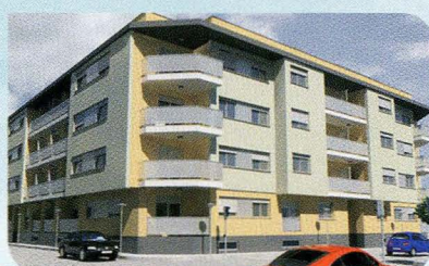
Edificio Villa Inés Moncófar
