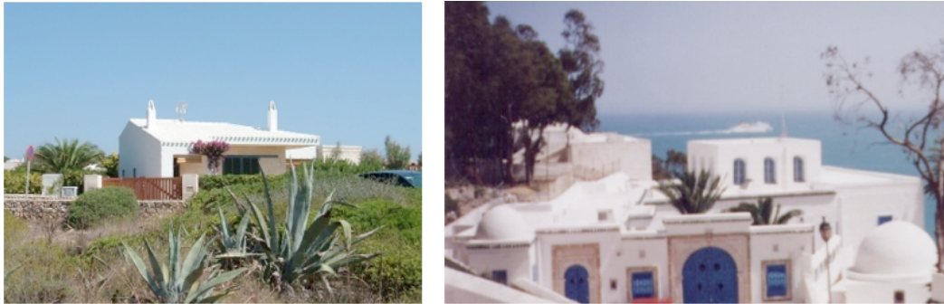
Figuras 2 y 3. Edificios encalados en Menorca y Sidi Bu Said (Túnez)
