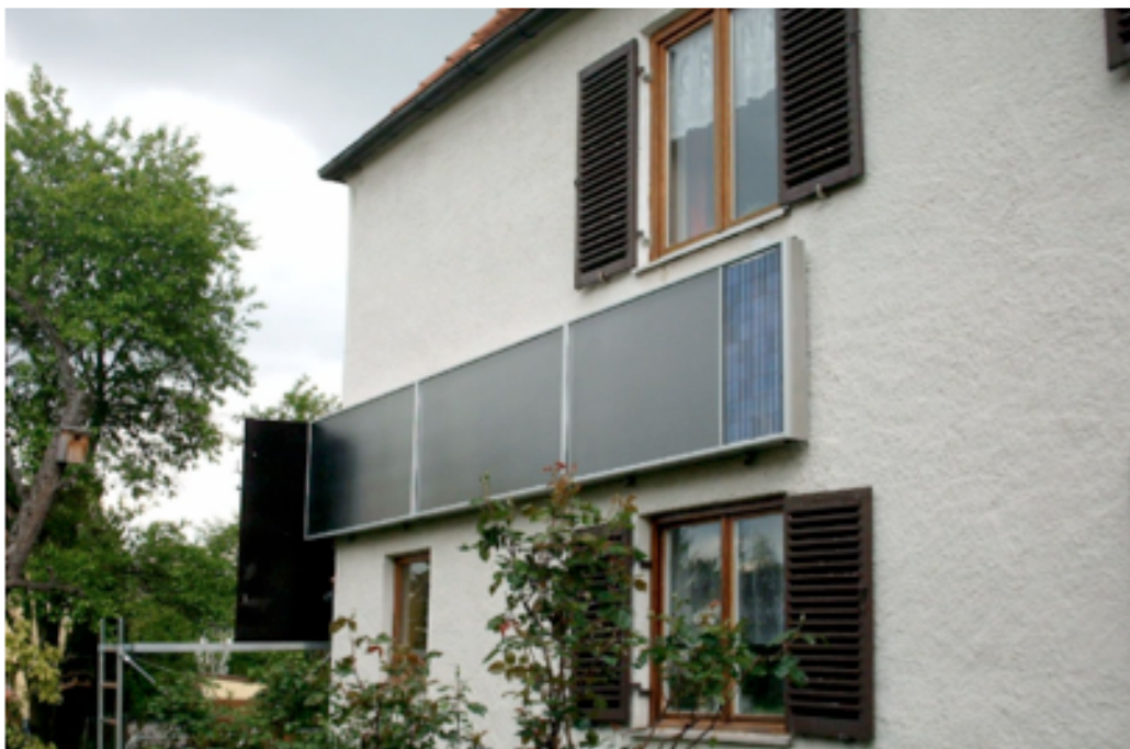
Figura 9. Colectores planos de aire. (Fuente: Grammersolar)
