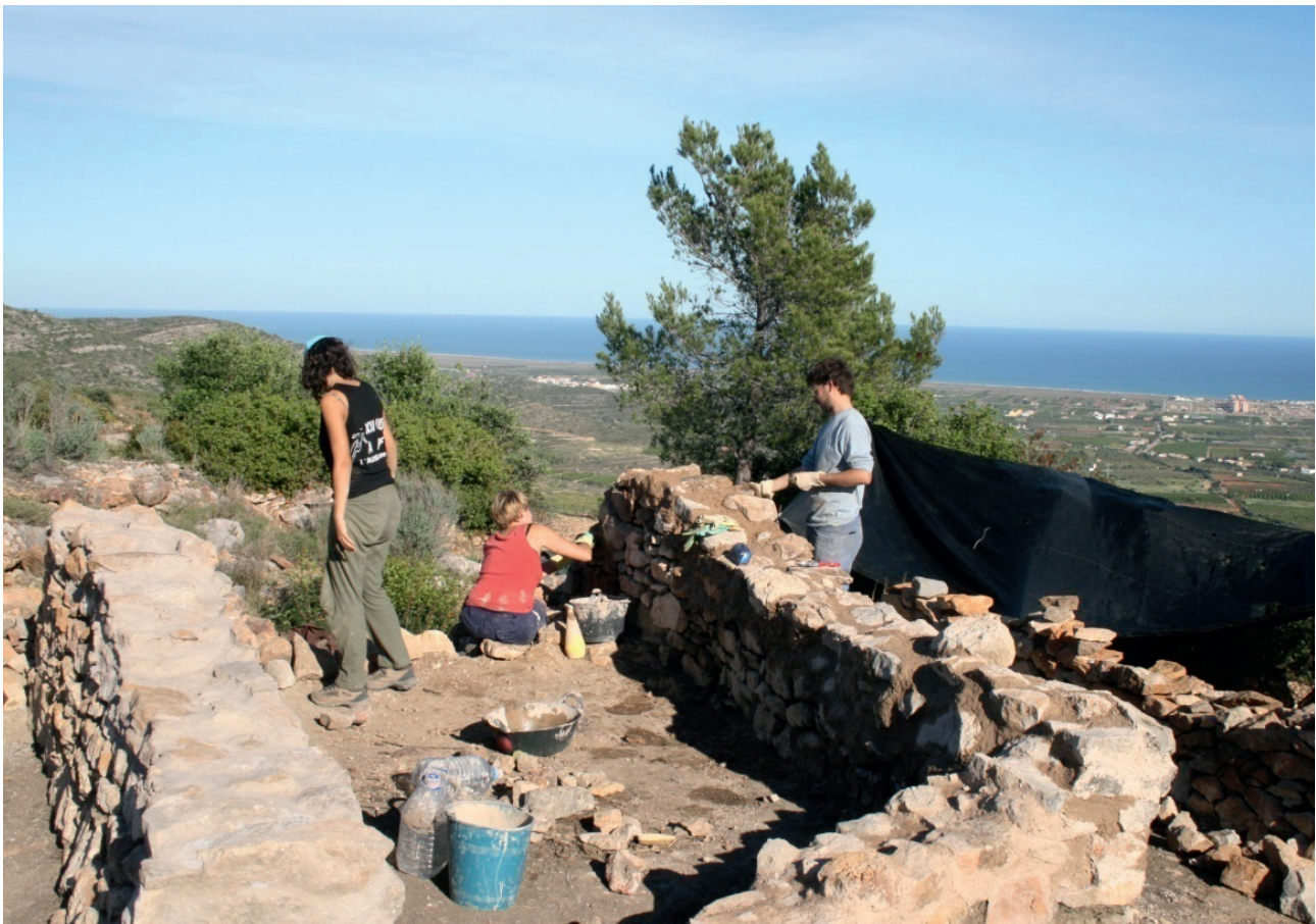
Figura 5.3. Treballs de consolidació del mur UE. 1002.
