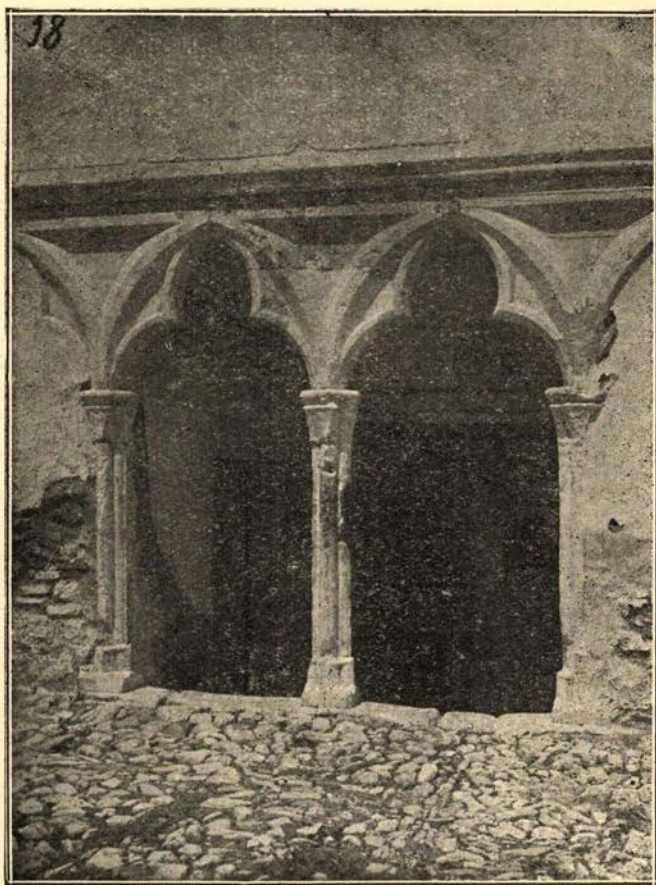
Detalle del claustro de San Francisco.
