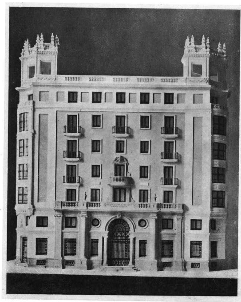
Fachada a la calle de Colón
