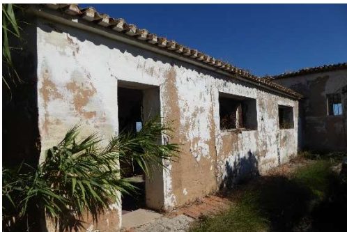
Façana sud zona planta quadrada
