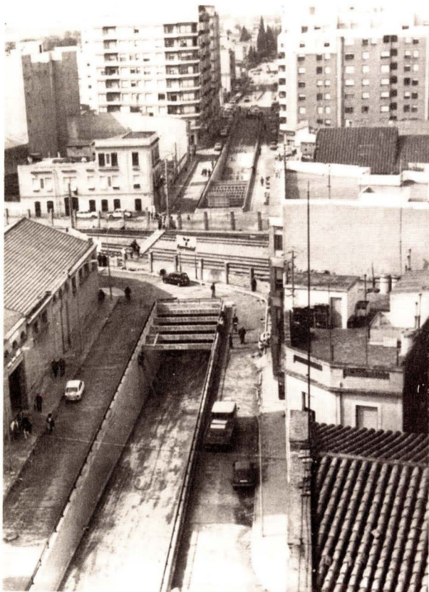
EL TAN ESPERADO PASO SUBTERRANEO DE LA AVENIDA DE ALCORA ES ¡POR FIN!, UNA REALIDAD
