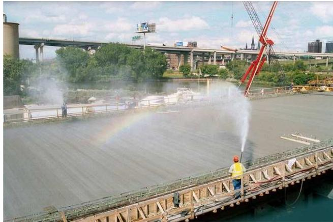
Figura 6. Curado de una losa de hormigón armado
