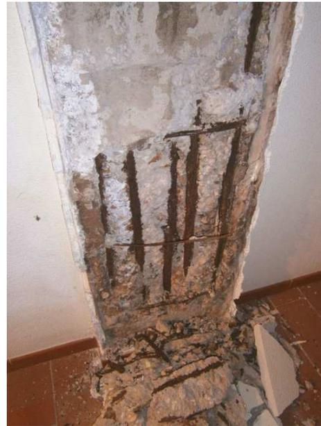
Figuras 3 y 4. Colapso de hormigón estructural en pilar
