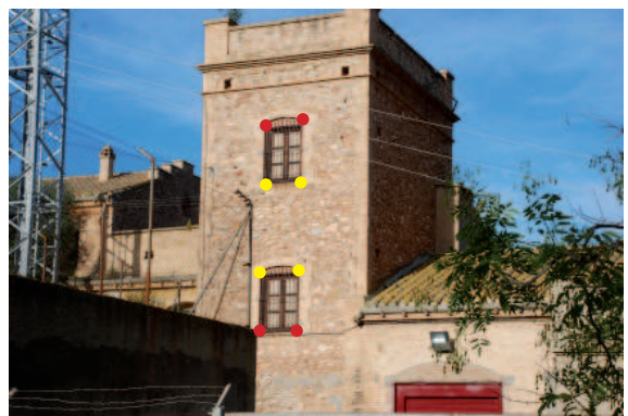
Toma de puntos lateral Torre principal
