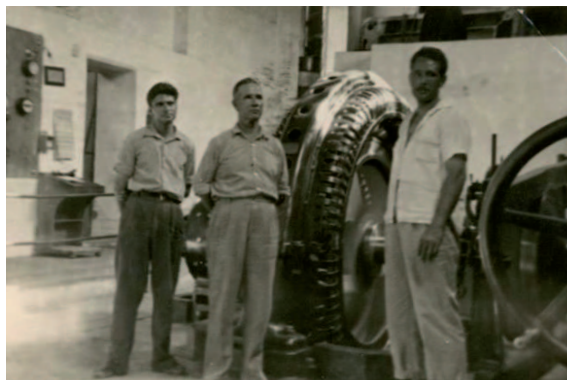
Vista interior de la Central Hidroeléctrica Fuente: Carlos y Vicente Amiguet
