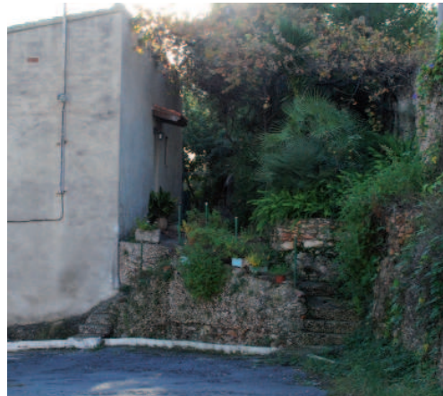
Detalle de la escalera desde la que se accede a la planta segunda por el exterior de la vivienda.
