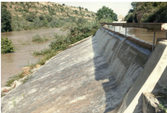
Aliviadero del canal de la Llum de Tol
