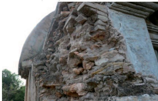
Mampuestos del muro de carga
