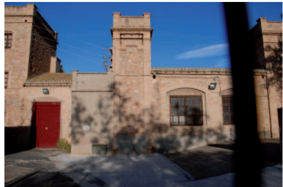
Vista frontal de torreta, a través del vallado
