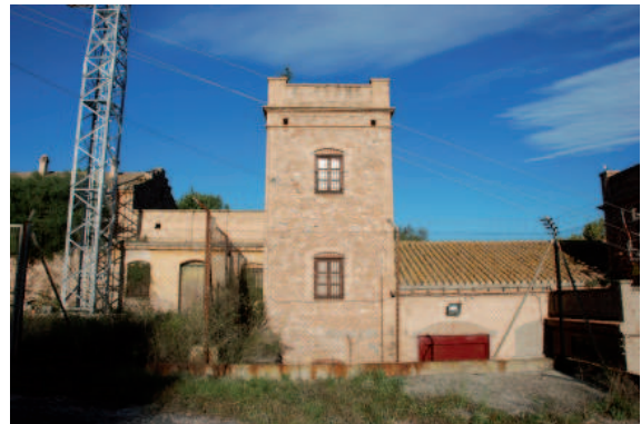
Vista frontal de torre, imposibilidad ver completa la torre.
