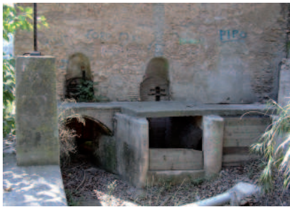
Entrada del canal en el molino
