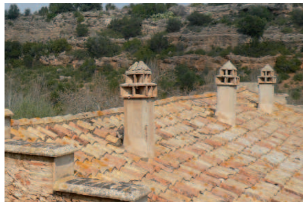
Detalle de las tres chimeneas que siguen en pie, en el conjunto de viviendas adosadas junto a la central
