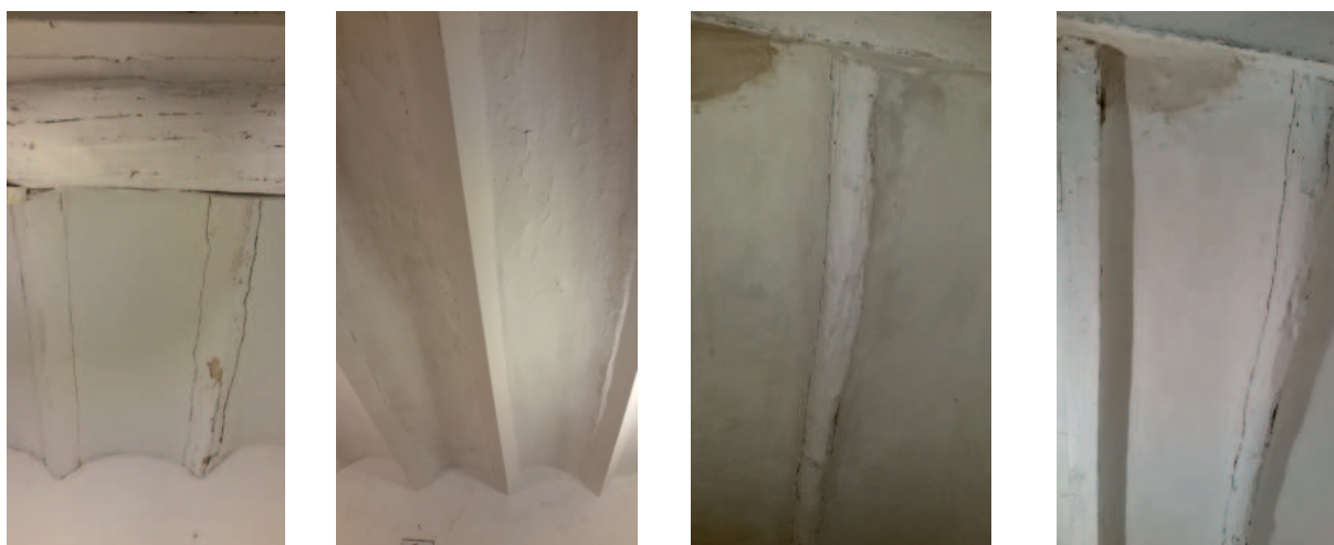
Detalle de las diferentes tipologías de viguetas que se encuentra en la vivienda de la familia Amiguet
