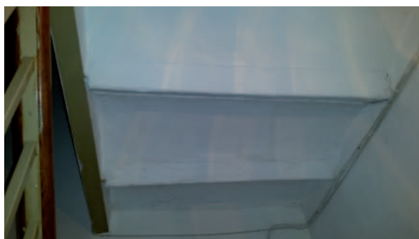
Detalle de zuncho metálico en la abertura del forjado para el apso de escalera interior
