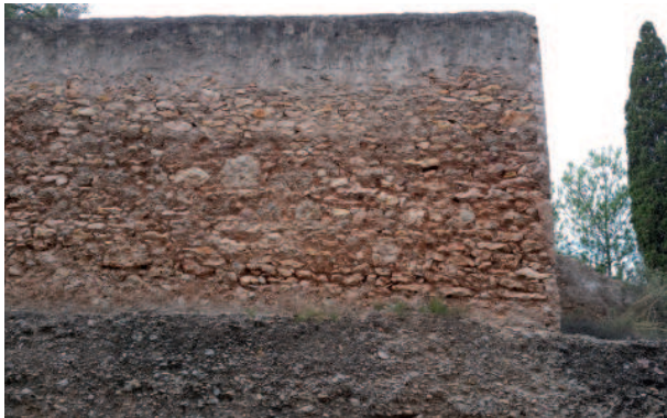
Muro de mampostería del vaso que conforma el perímetro del recinto donde se ubica la capilla.
