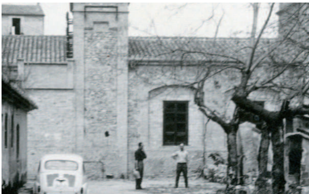
Imágen de antes de la ampliación de ventanas en fachada este Fuente: Carlos y Vicente Amiguet
