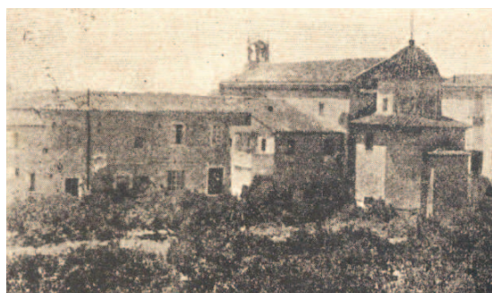
Vista exterior de la iglesia Hospital, 1909. Traver Garcia, Benito
