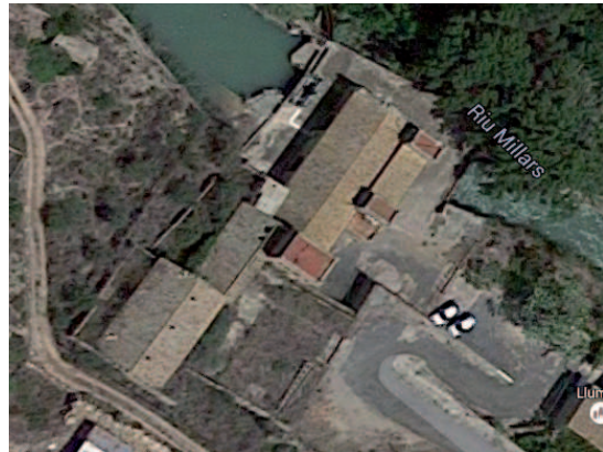
Vista de cubiertas de las instalaciones. Visor geográfico virtual Fuente: Google.maps
