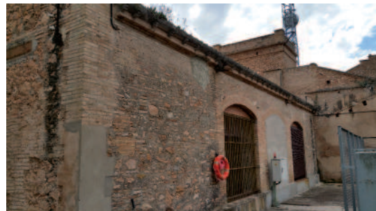
Fachada Oeste del cuerpo central de la Central
