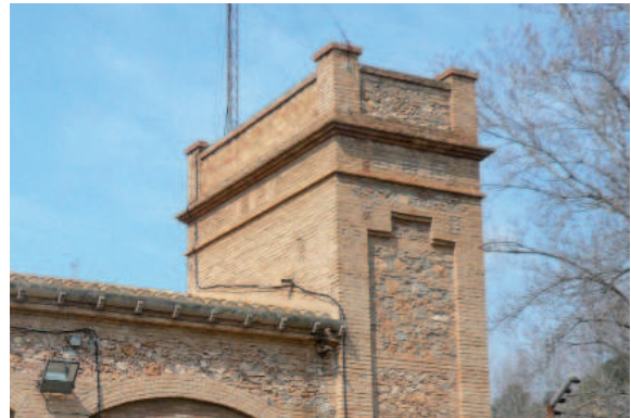
Detalle fachada sur de la torre cercana al canal. Paño ejecutado por completo con ladrillo macizo. Fuente: Autor
