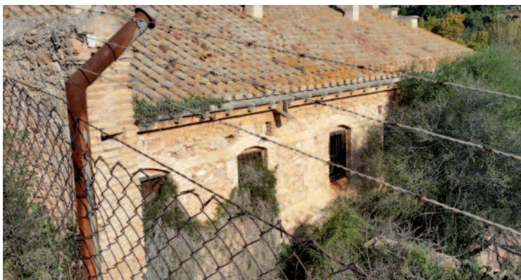
Fachada principal del conjunto de viviendas, muro de carga de mampostería ordinaria con verdugadas
