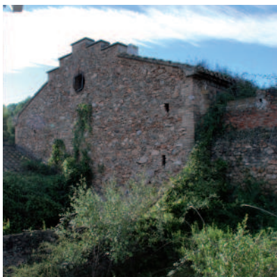
Hastial de conjunto de viviendas, realizado con mampostería de cal y canto
