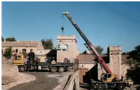
Momento del cambio de turbinas de mayor voltaje Fuente: Televisión de almassora
