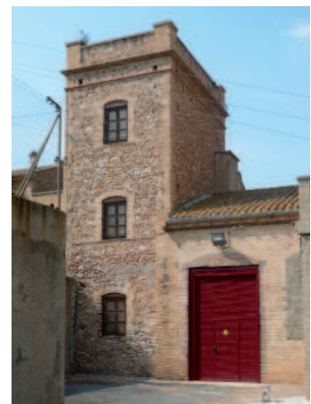
Puerta metálica, en hueco de ventana Fuente: Autor
