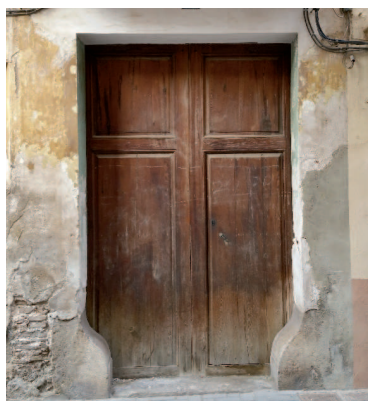
Entrada de casa, conocida como “entra de carro” con guardaesquinas de piedra
