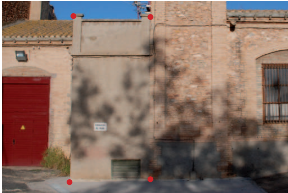
Toma de puntos torre pequeña
