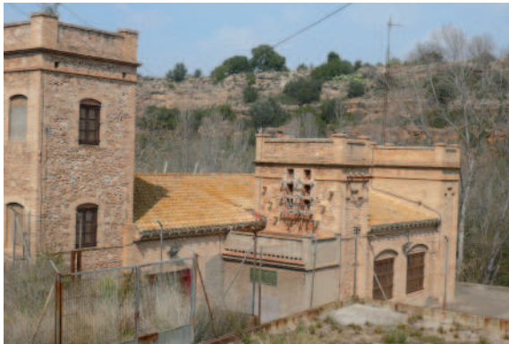
Vista de las fachadas Sur de las torres
