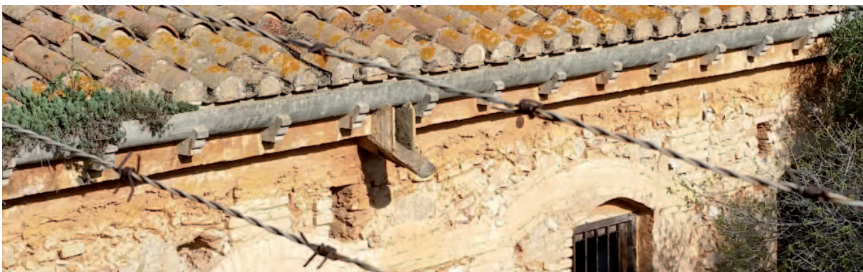
Detalle de canal, sujeciones y desagüe de canal, del conjunto de viviendas adosadas junto a la central
