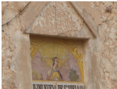
Retablo de Sta. Sofia en la fachada principal
