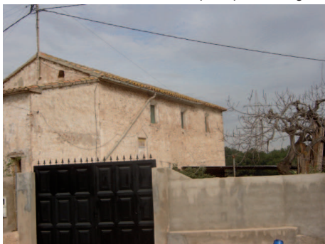
Vista del acceso actual del molino
