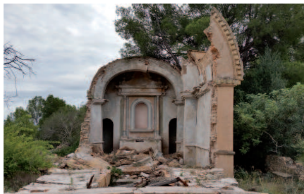
Vista frontal del estado actual de la capilla
