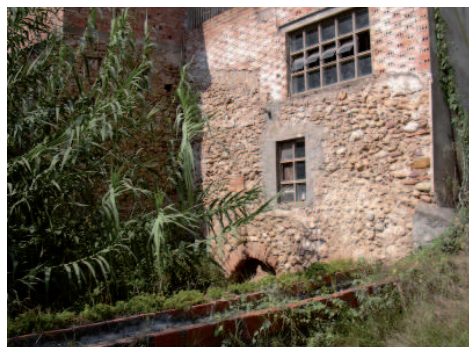
Vista fachada posterior
