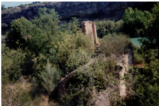
Molí d'en Llop_ Restos de muros_
