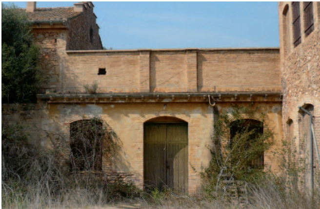
Detalle de arcada de ladrillo cerámico macizo en el muro de carga interno de la vivienda del encargado.
