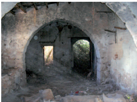
Molí de la Roqueta_ Interior planta baja_
