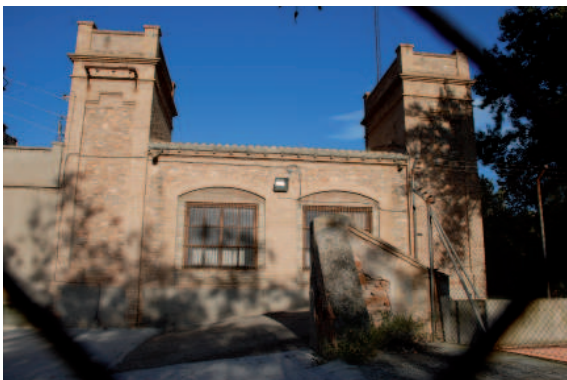
Vista frontal de nave, machón impidiendo ver todos los puntos
