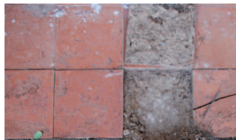
Detalle de azulejo de barro cocido de 20x20 cm. Dispuesto en el solado de la capilla
