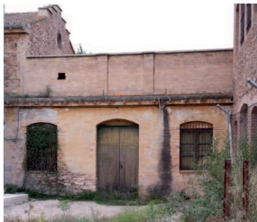
Fachada principal de la casa del encargado
