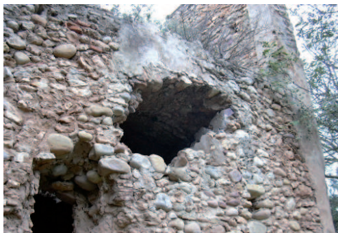
Molí d'en Llop_ Muros de mamposteria_
