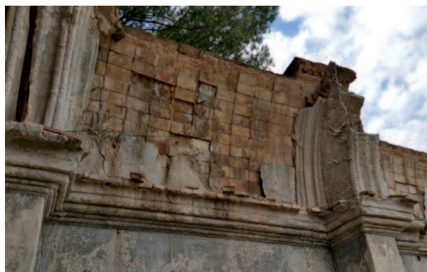
Vista del lateral sur interior de la capilla Fuente: Autor
