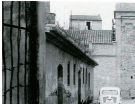
Detalle del alero de cubierta del conjunto de viviendas desde la casa familiar de Pasqual Amiguet. Fuente: Carlos y Vicente Amiguet
