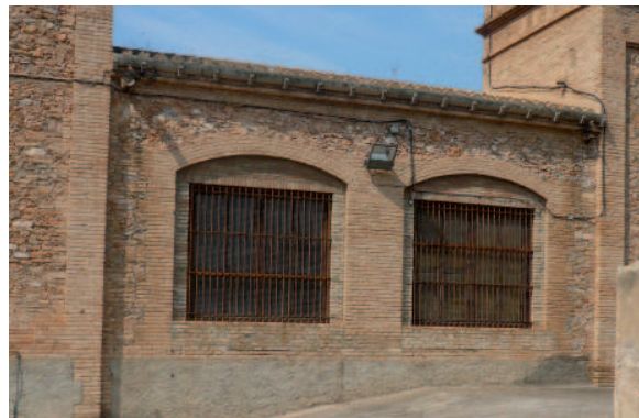
Imágen de después de la ampliación de ventanas en fachada este
