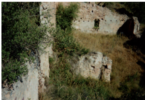
Molí d'en Llop_ Muros de mamposteria_
