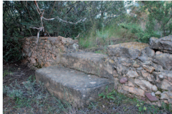
Peldaños del segundo acceso, situado en el lateral sur de la capilla Fuente: Autor
