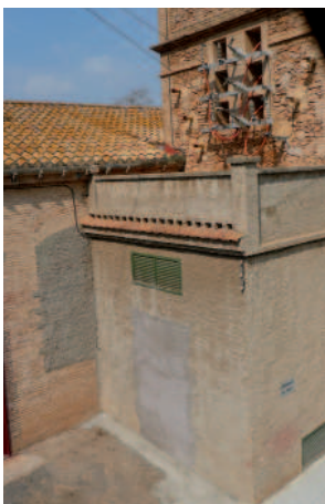
Puerta y ventana cegada
