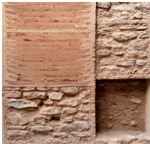
Muro tapial en los restos de la muralla de Vila-real
