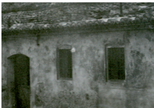
Detalle de revoco del conjunto de viviendas situadas junto al acceso a la fábrica
