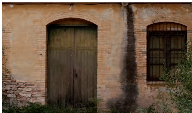
Detalle del revestimiento de fachada de la vivienda del encargado.
