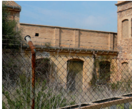
Detalle de pilastras de ladrillo cerámico macizo en el muro de carga interno de la vivienda del encargado.
