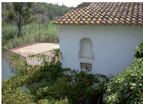
Vista fachada lateral
