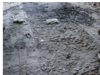
Entrada de casa con pavimento de piedras de río aplanadas, formando dibujos
