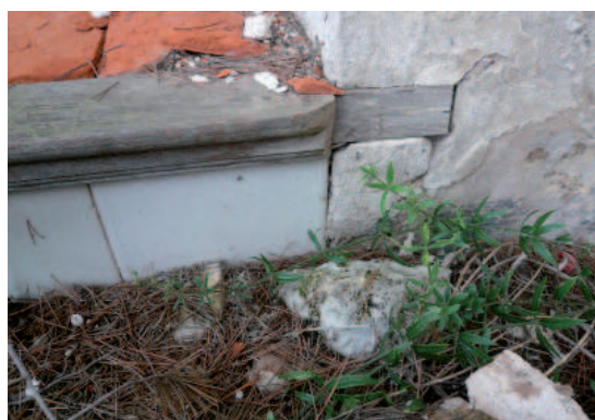
Tabica de azulejo de pasta roja en blanco 20 x 20 cm. y mamperlán de madera
