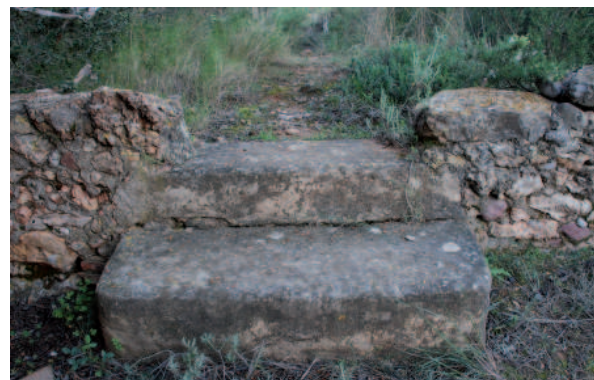
Peldañado del segundo acceso a la capilla Fuente: Autor
