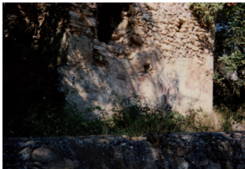
Molí d'en Llop_ Muros de mamposteria_
