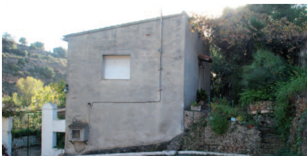
Detalle del revestimiento actual de fachada de la vivienda familiar de Pascual Amiguet.
