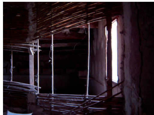
Detalle de separación realizada con cañizo y argamasa. La imagen pertenece a la Alquería dels Frares de Vila-real.
