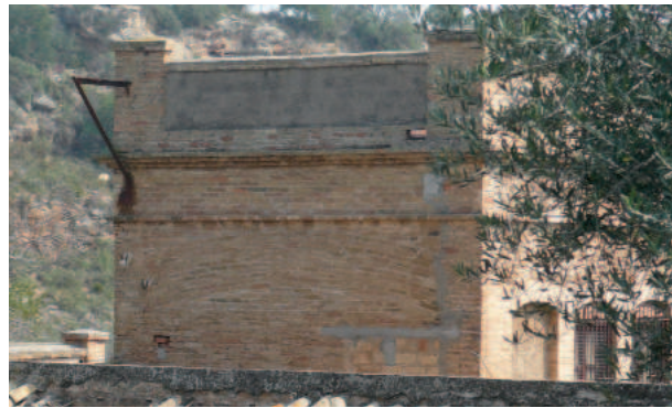
Detalle fachada oeste de la torre principal. Arcada de ladrillo macizo. Fuente: Autor
