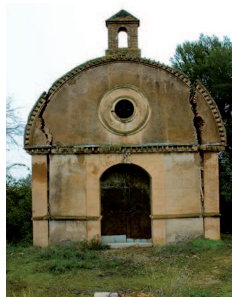
Vista de la fachada principal de la capilla Fuente: Carlos y Vicente Amiguet
