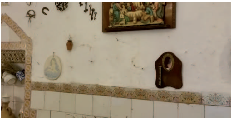
Vista interior de muro de carga, aprovechando talud del terreno
