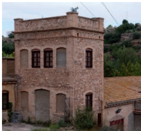
Puerta y ventana cegada y originales de la torre principal
