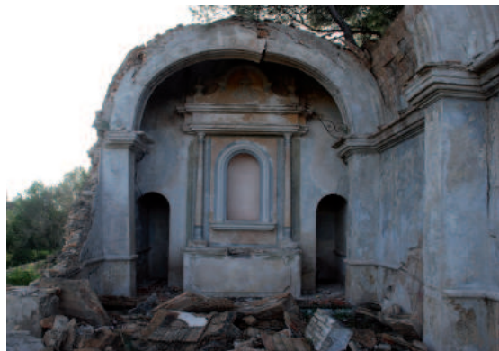
Pórtico de pilares y arco de medio punto de fábrica de ladrillo
