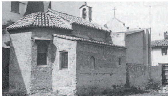
Vista exterior de la iglesia Hospital, 1909. Traver Garcia, Benito
