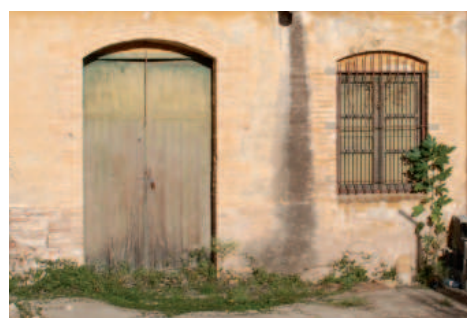
Detalle carpintería exterior de vivienda del encargado
