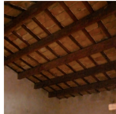
Detalle de cubierta con base de rasillas cerámicas. Pertenece a una alquería del término de Vila-real. Fuente: Autor
