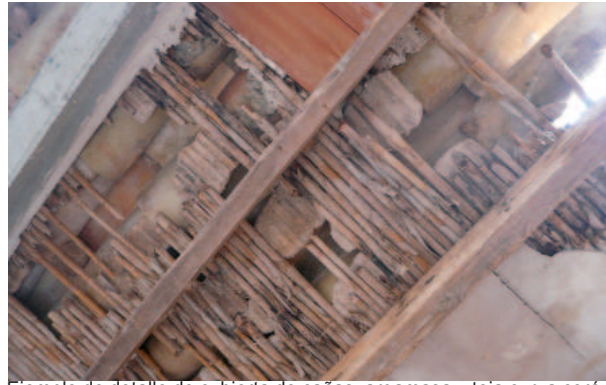
Ejemplo de detalle de cubierta de cañas, argamasa y teja curva cerámica. Pertenece a alquería del término de Vila-real
