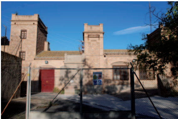
Vista frontal de torreta, con vallado impidiendo ver los puntos.
