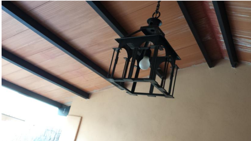
Imagen 3.14. Cubierta inclinada garaje.
