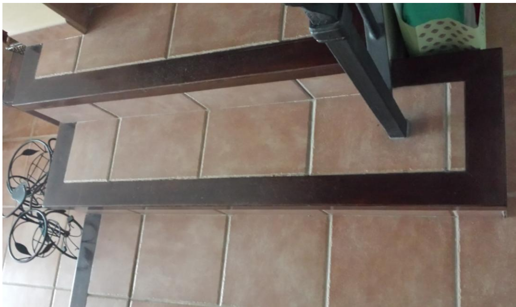
Imagen 3.18 .Pavimento de gres y mamperlán de madera.
