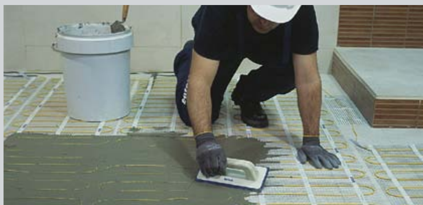
Detalle del proceso de colocación de la malla eléctrica.
