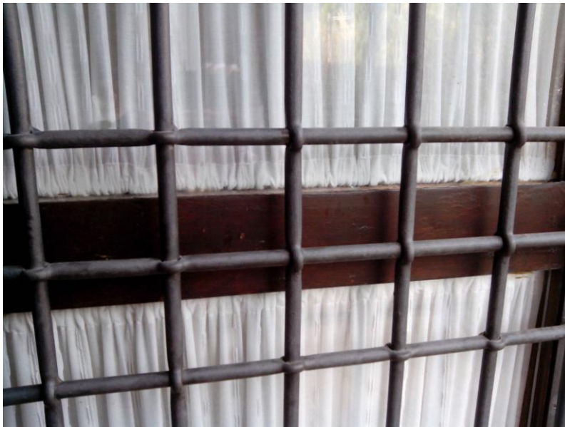
Imagen 3.25. Detalle cerrajería puerta de entrada a vivienda.
