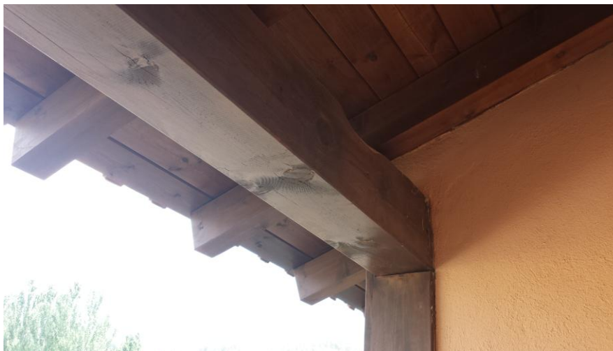
Imagen 3.13. Cubierta inclinada balcón habitación 1.
