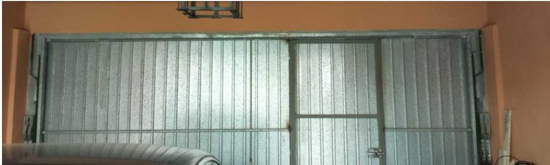
Imagen 3.27. Puerta metálica de acceso a garaje.
