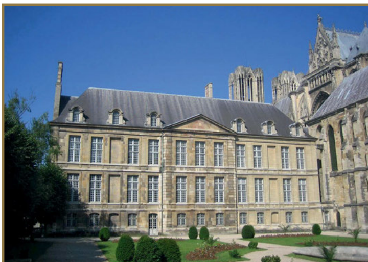
Palacio de Tau Arrière.
