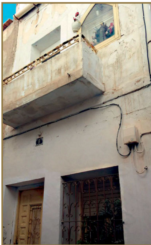
Capilla de San Pascual, en la fachada de la casa.
