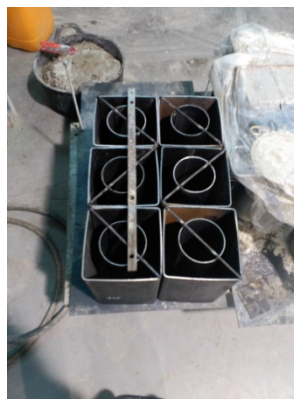
Ilustración 4. Soldadura de los perfiles de acero.
