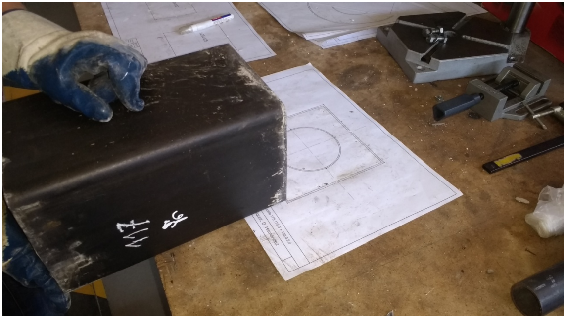
Ilustración 5. Marcado de los pilares.
