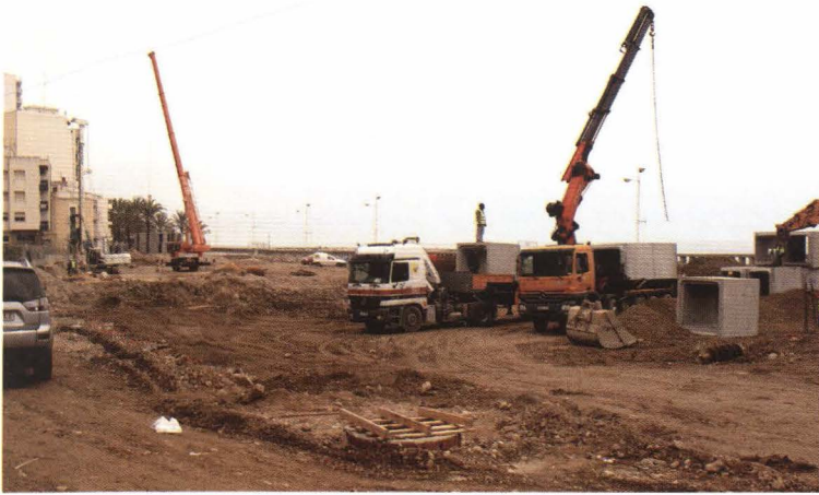
Obres de la segona fase del passeig, en una imatge presa el passat dimarts
