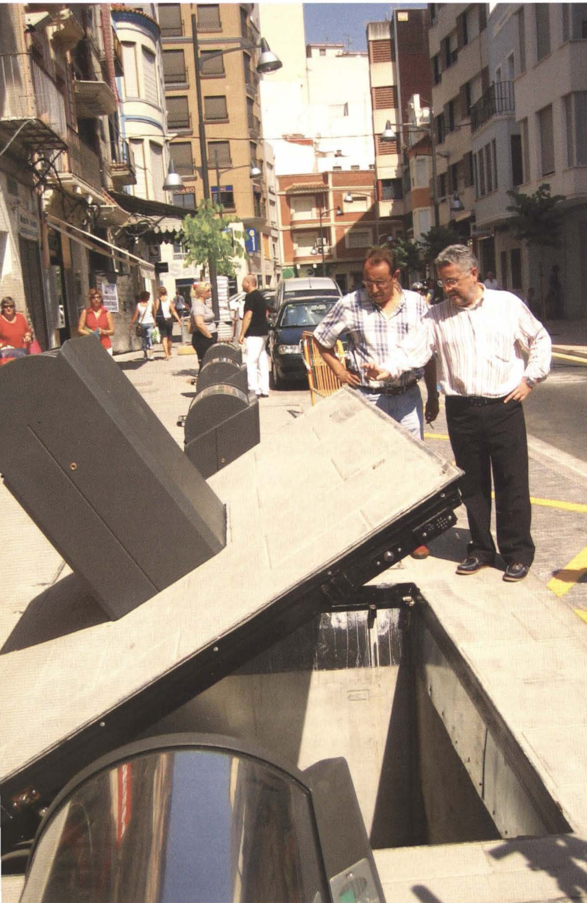
L'alcalde, Jordi Romeu, i el regidor d'Urbanisme, Javier Balada, van realitzar una demostració del funcionament dels contenidors soterrats
