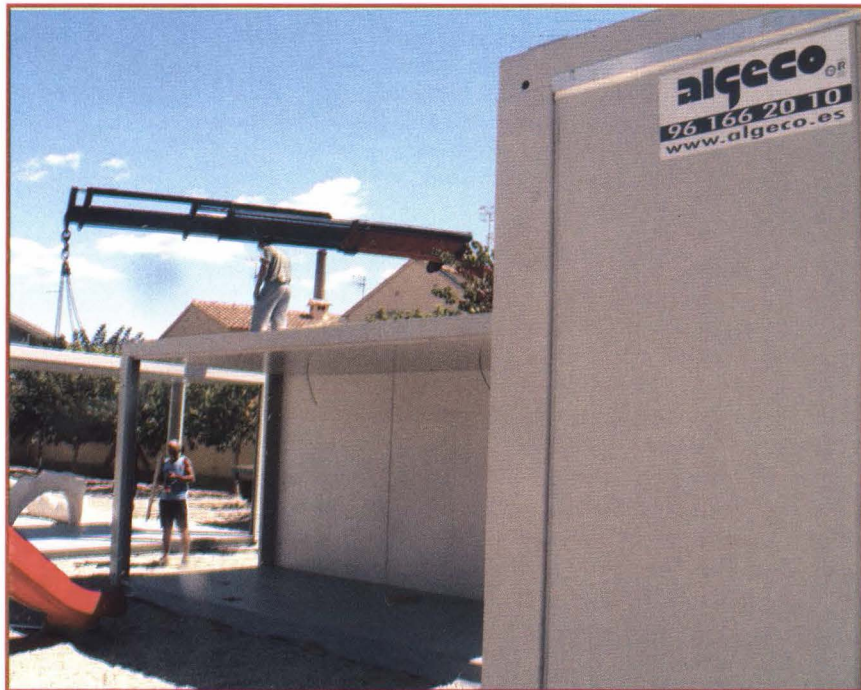
Les aules prefabricades es van instal·lar la setmana passada al Manuel Foguet
