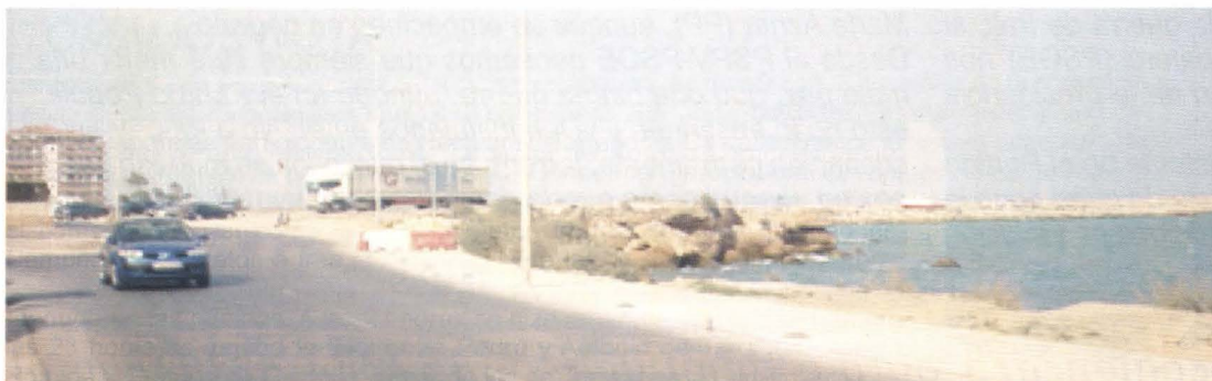
Punto de inicio de las obras del Paseo de Ribera
