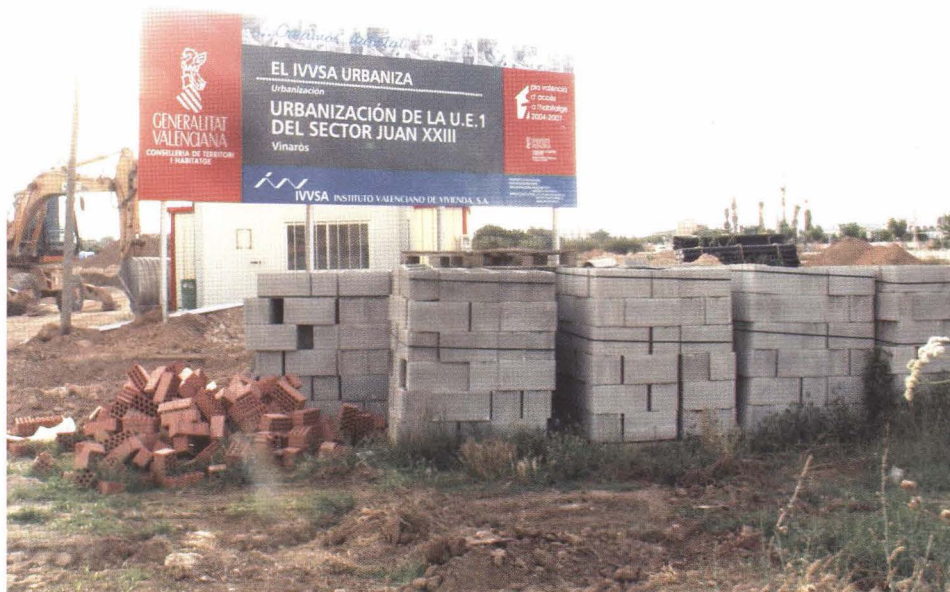
Obres d'urbanització de Joan XXIII a Vinaròs on l'IVVSA construirà vivendes de protecció oficial
