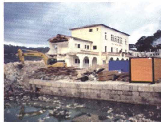
Puerto de Sóller - Derribo Base Naval
