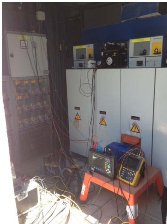
Ilustración 4. Conexión analizador de redes
