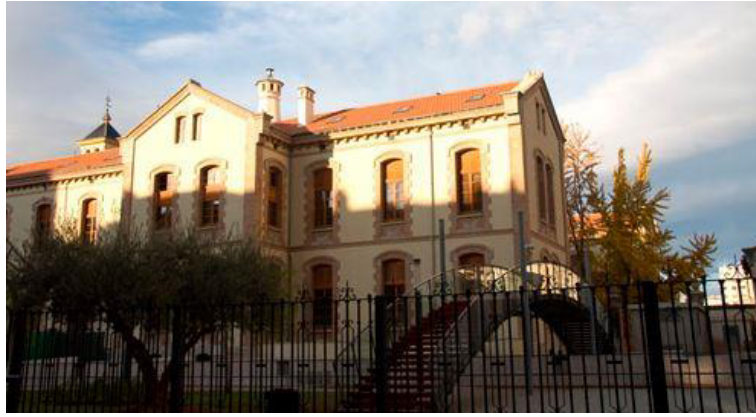
Imagen 2: Ala noreste del edificio Montesinos.
