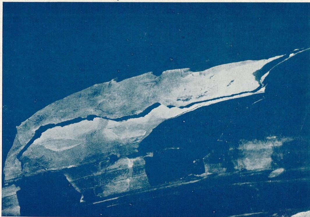
Grieta producida por la expansión de los gases, donde se ve la separación de las dos capas «ARRICCIATO» e «INTONACO»
