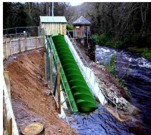
Figura 13. Tornillo de Arquímedes generador.
