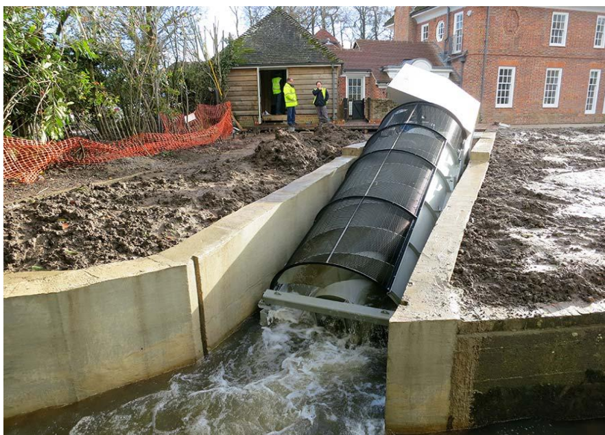
Figura 22. Estructura de obra civil con canal de rejillas.
