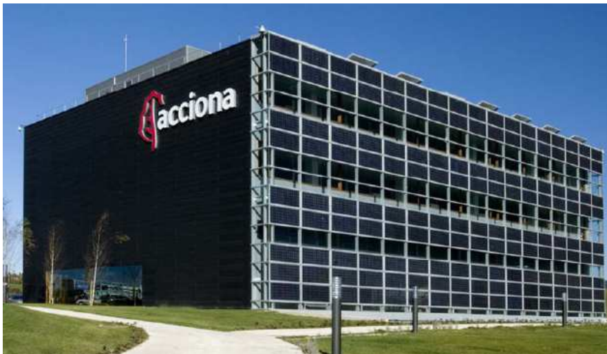
5.5. Fachada fotovoltaica de la sede de ACCIONA SOLAR en Navarra. Fte: deltoroantunez.com
