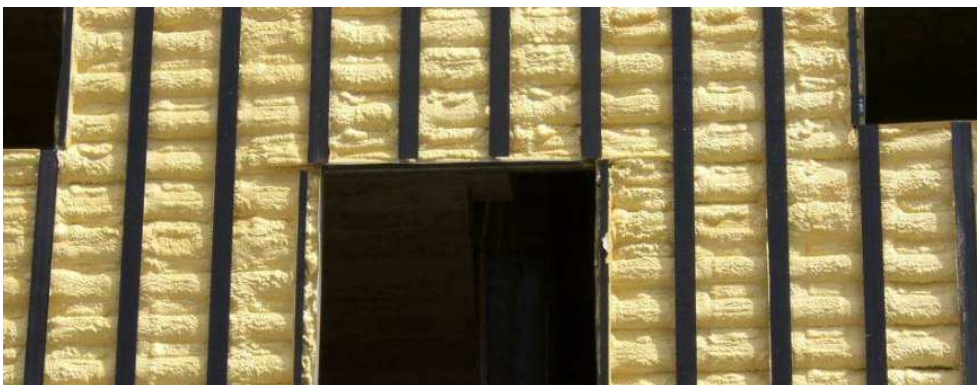
7.4. Imagen de una fachada ventilada aislada con poliuretano proyectado. Fuente: optimoaislamiento.com
