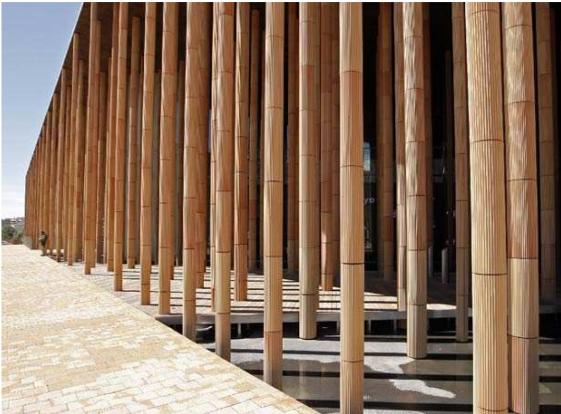
5.16. Imagen de los troncos cerámicos del Pabellón de España en Expo Zaragoza 2008. Fuente: ceramicarchitectures.com
