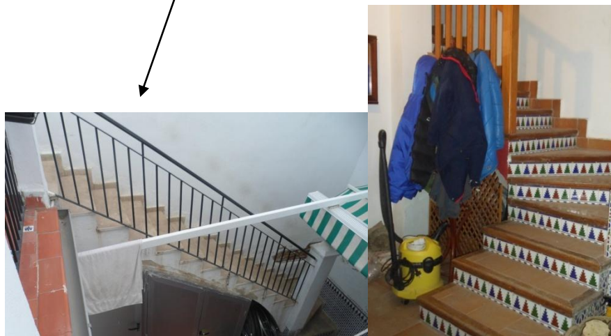
Ilustración 20 y 20, Escaleras. Fuente: Propia
