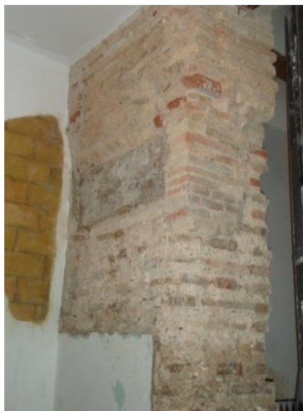
Ilustración 18, Pilar interior Fuente: Propia
