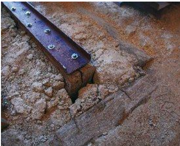
Ilustración 42. Forjado con la pieza de refuerzo ensamblada, texto_Carlos González-Bravo
