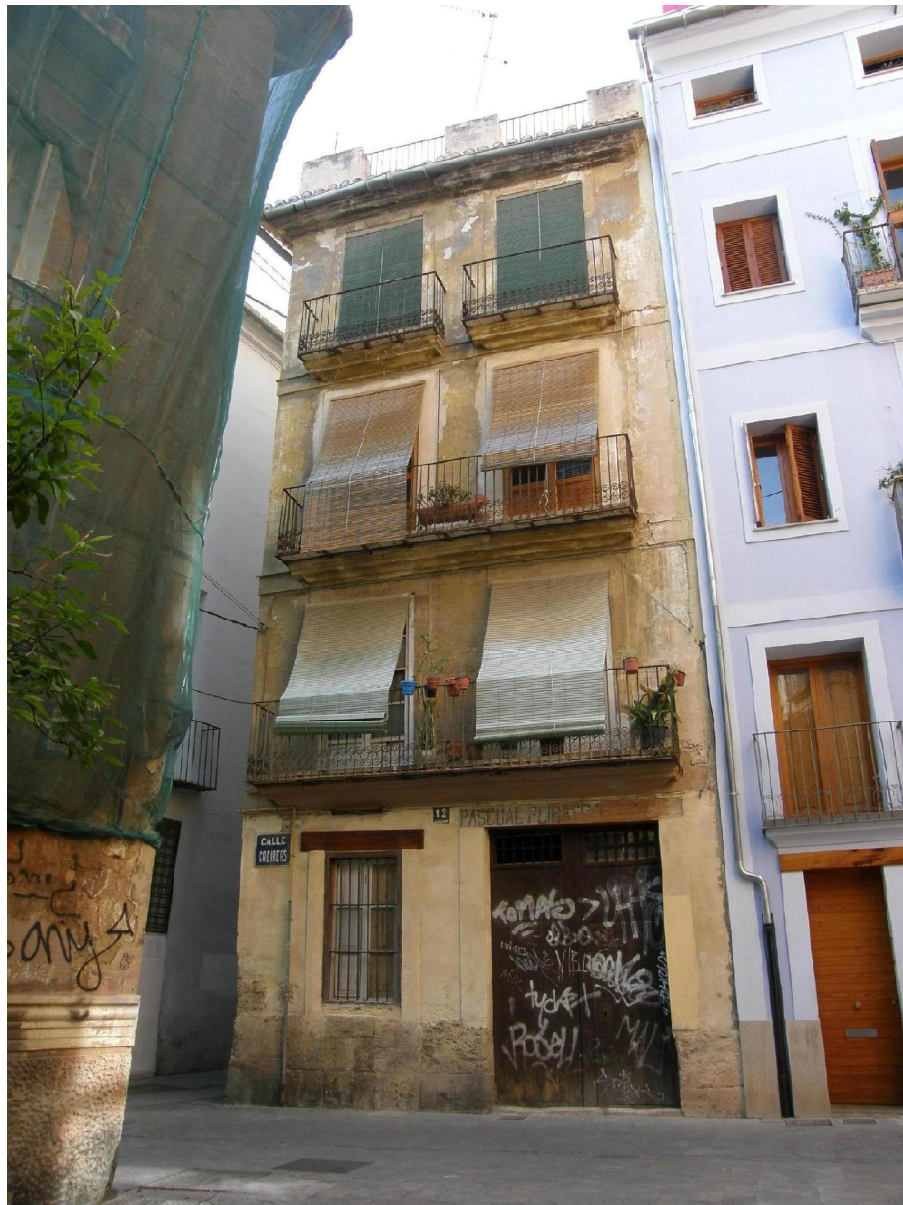
Fotografía de la fachada principal
