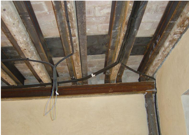
Ilustración 47. Refuerzo de forjado, portal web ardi.cad
