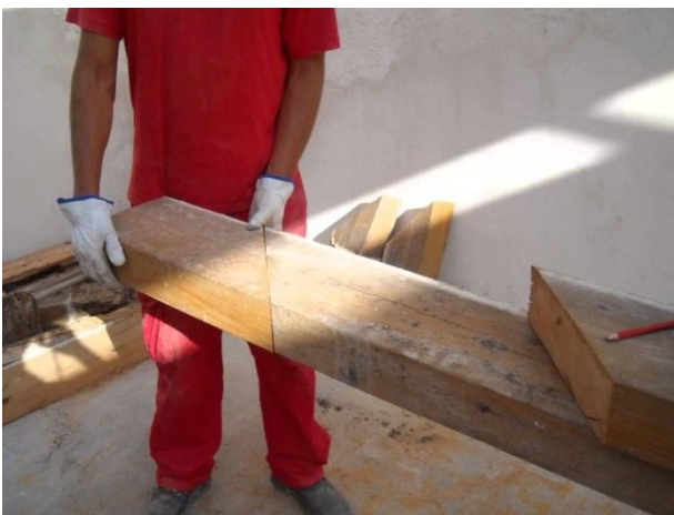
Ilustración 38. Colocación prótesis de madera, portal web vestalia.es restauración de estructuras de madera
