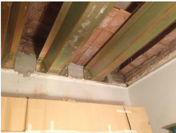
Ilustración 44. Estado final de la intervención, portal web mecanoviga.com
