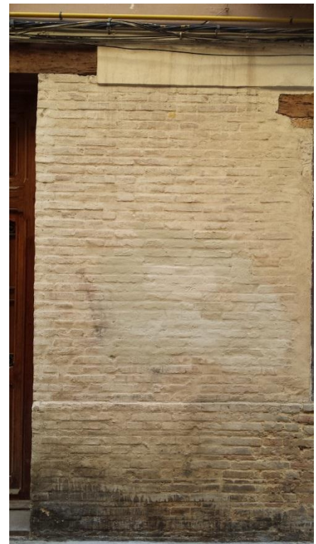
Ilustración 4. Acabado muro bajo
