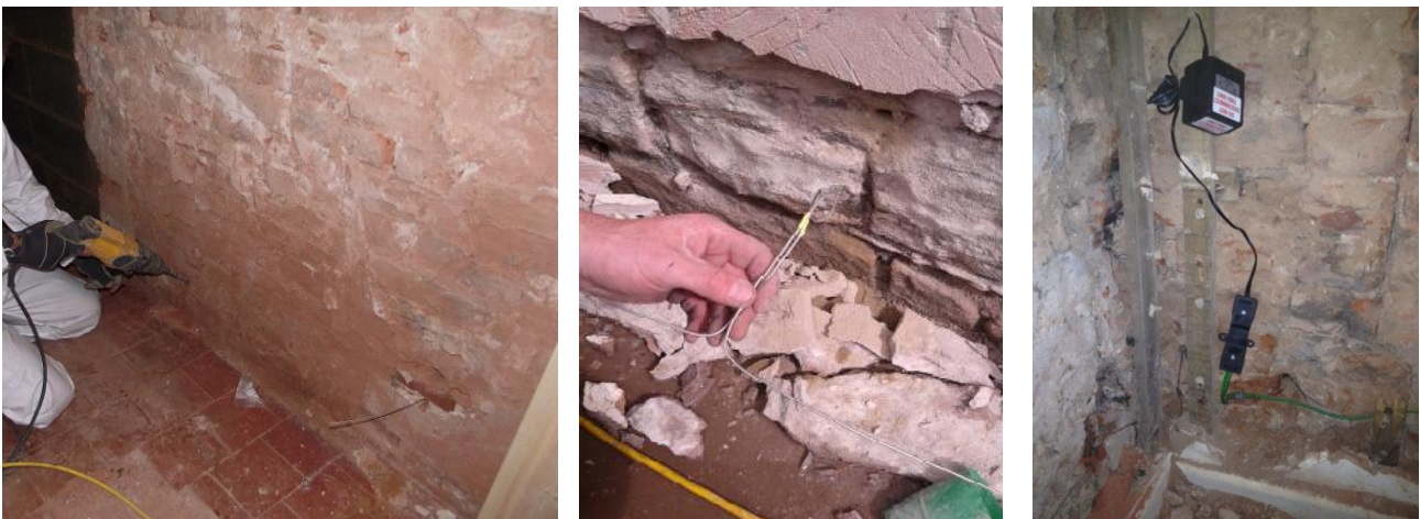
Ilustraciones 34. Electro-osmosis activa, galería de imágenes web Timberwise
