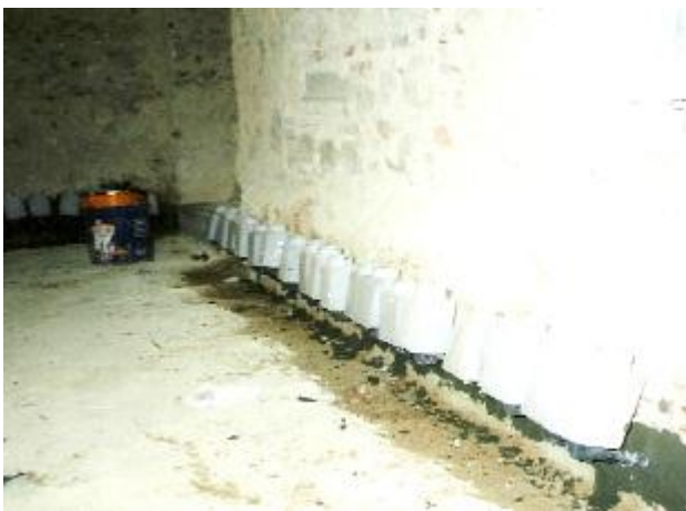
Ilustraciones 33. Sistema de deshumidificación y barrera química, catálogo web Kimia Ibérica
