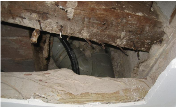
Ilustración 24. Vigueta segundo forjado
