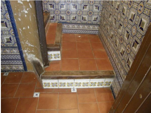
Ilustración 18. Pavimento y alicatado zaguán
