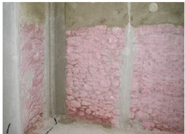
Ilustraciones 33. Sistema de deshumidificación y barrera química, catálogo web Kimia Ibérica
