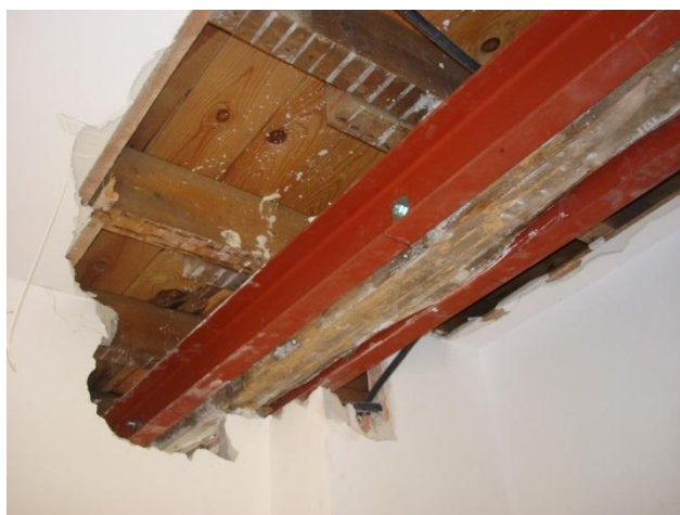
Ilustración 48. Refuerzo de estructura, portal web mendiaymurua.com
