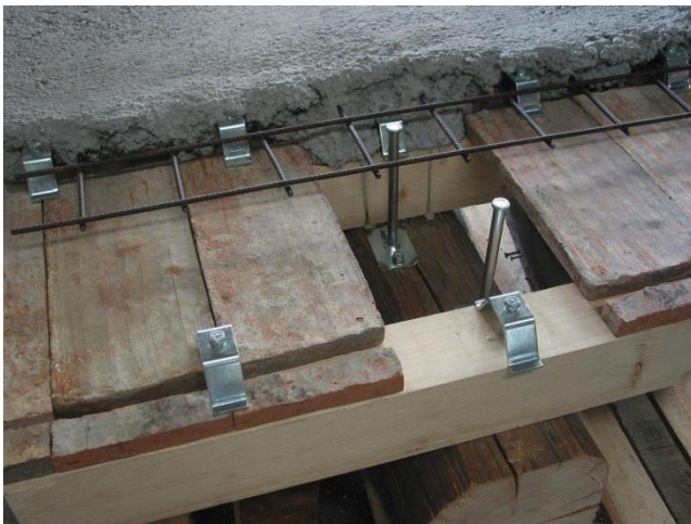
Ilustración 40. Detalle constructivo conectores, portal web edilportale.com
