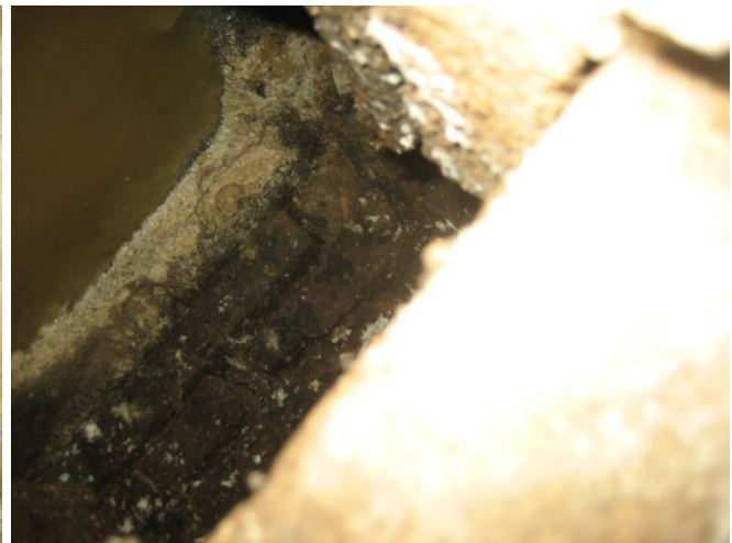
Ilustración 26. Condiciones interiores de la arqueta
