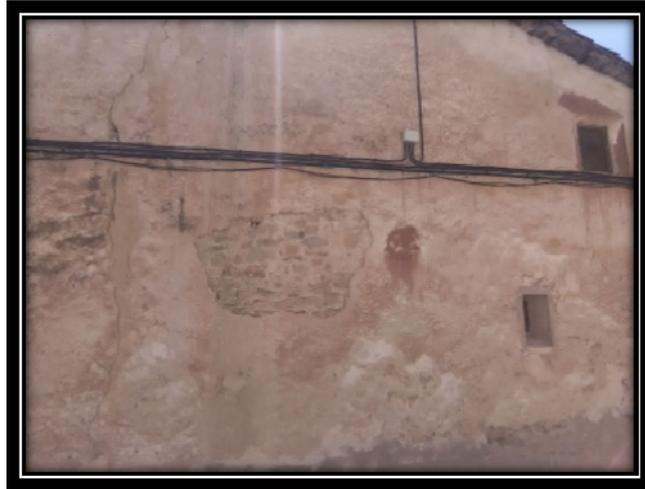
Imagen 14. Fachada enlucida con zonas en que se aprecia la mampostería del muro (Nogueruelas)
