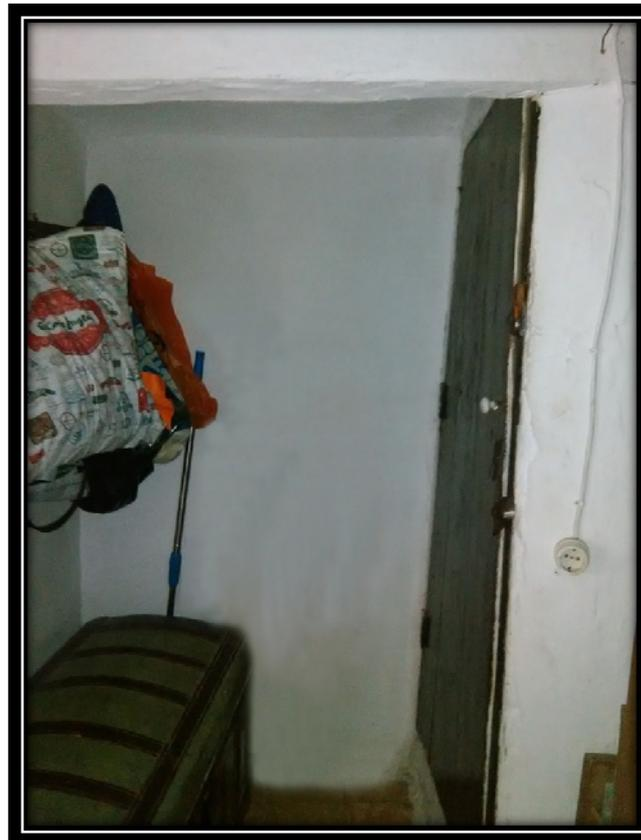
**Imagen 38. Muro por el interior enlucido con yeso y pintado**
