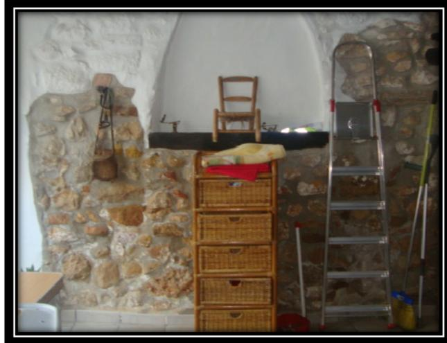
Imagen 11. Muro interior de piedra caliza y mortero de cal (Mosqueruela)
