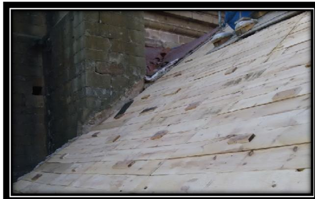
**Imagen 25. Entablillado de madera en forjado de cubierta (Mora de Rubielos)**
