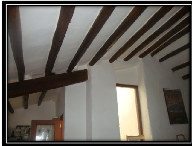
Imagen 24. Forjado de madera a dos aguas en vivienda (Mosqueruela)
