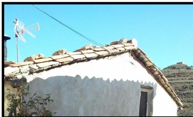
Imagen 49. Cubierta a dos aguas con teja cerámica curva
