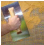
Mientras aún está fresco, colocar la malla ajustándola manualmente y presionando con la llana
