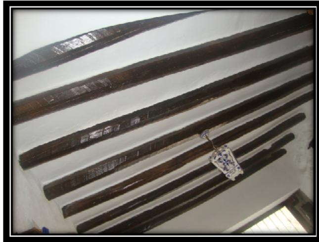
Imagen 16. Forjado con viguetas de madera (Mosqueruela)
