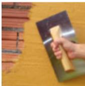
Aplicar una primera mano de mortero monocapa de la gama REVAT sobre el soporte
