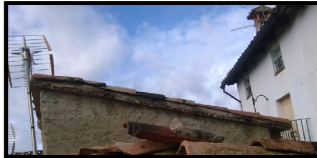
**Imagen 51. Cubierta a una agua formada por viguetas de madera y bardos cerámicos**
