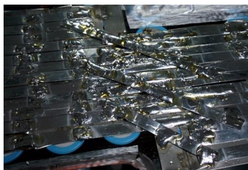
Ilustración 54: Detalle refuerzo en zona crítica
