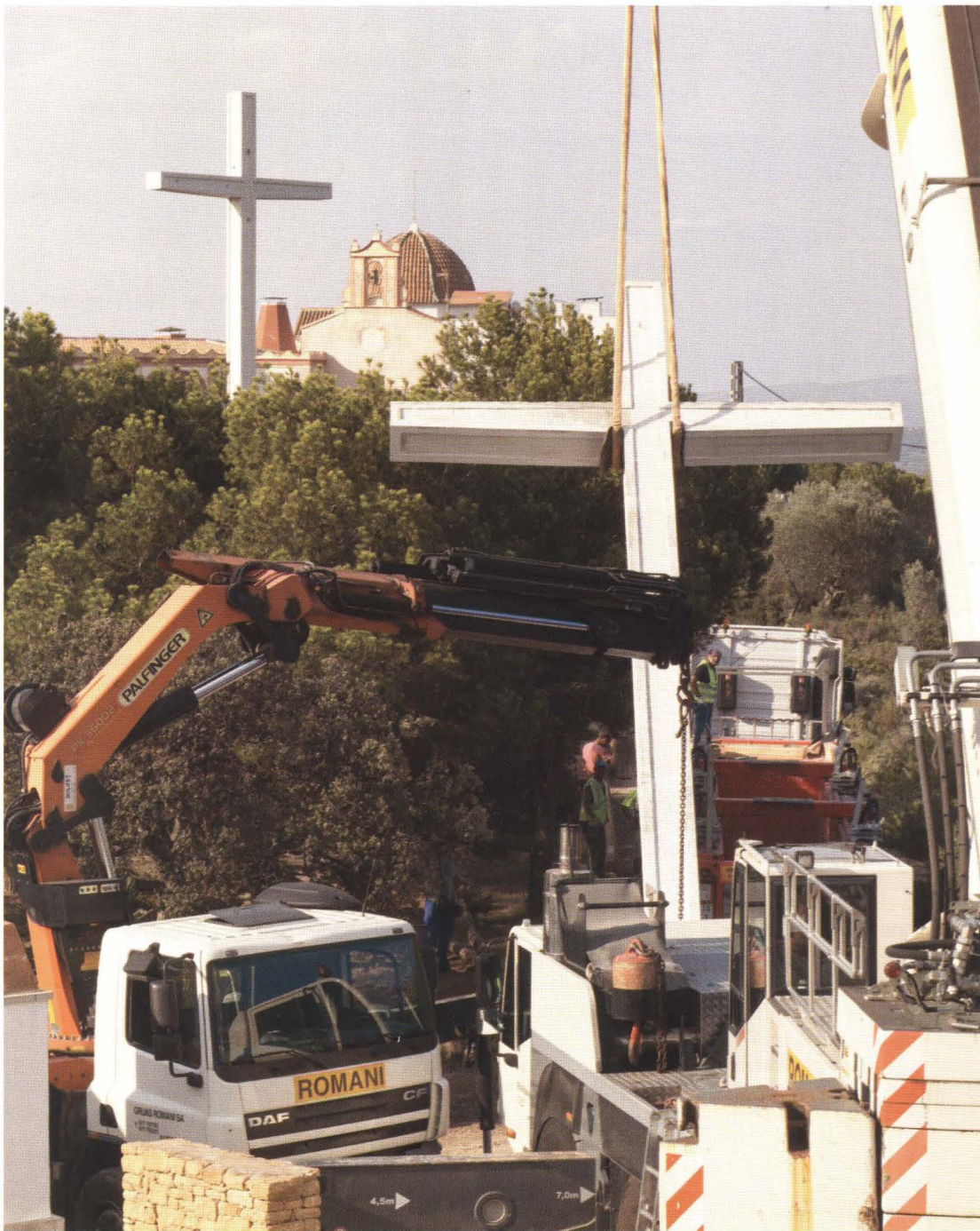
En la imagen, el momento en que se retira la antigua cruz. La nueva, ya instalada más cerca de la ermita, en la zona de la antigua era. Foto: Aparicio
