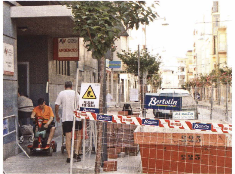
Las obras de mejora se han iniciado esta semana
