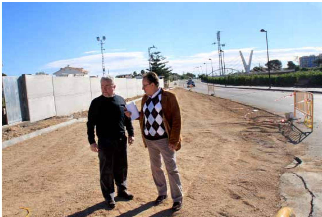
El primer edil, Jordi Romeu, junto al edil de Urbanismo, Javier Balada, en el punto donde se realizará la rotonda de la avenida del Cervol
