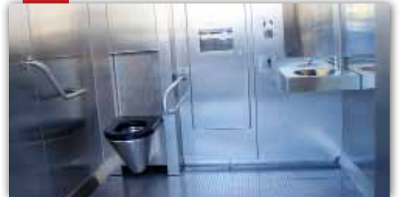
Se instala un nuevo lavabo público
