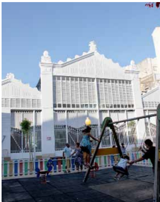
Vista de la façana del mercat, després de les obres de la primera fase
