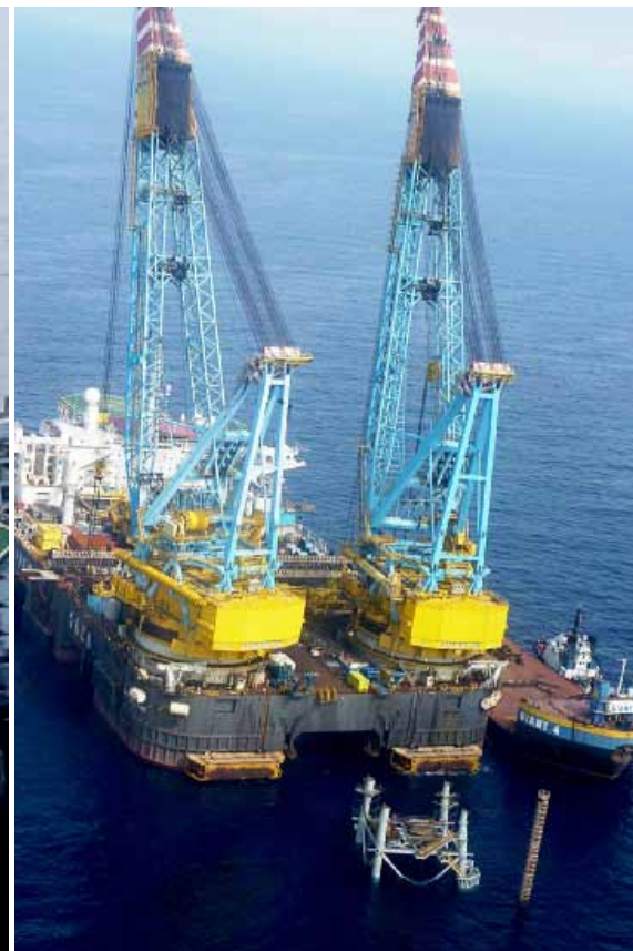
Vista Saipem 7000: Jacket instalado y primer pilote de anclaje
