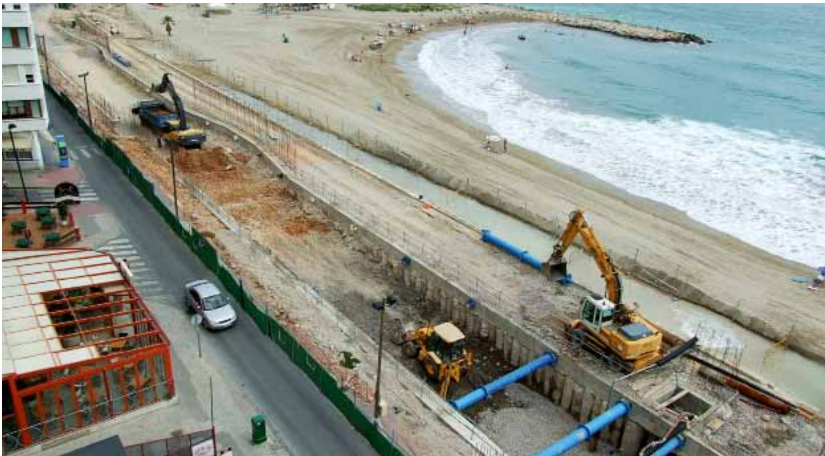
Des de dilluns, les obres del passeig marítim continuen després del parèntesi estival
