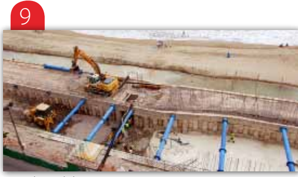
Les obres del passeig continuen
