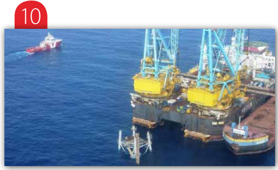
Plataforma marina de pozos
