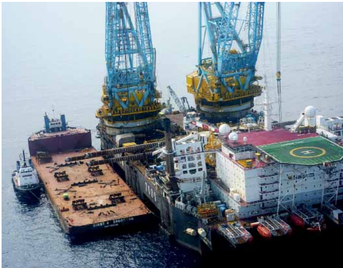
Imagen general de la Saipem 7000 con las dos grúas, la helisuperficie, el módulo de acomodación donde residen durante el montaje 400 personas. A su lado, la barcaza, que ha trasladado el jacket
