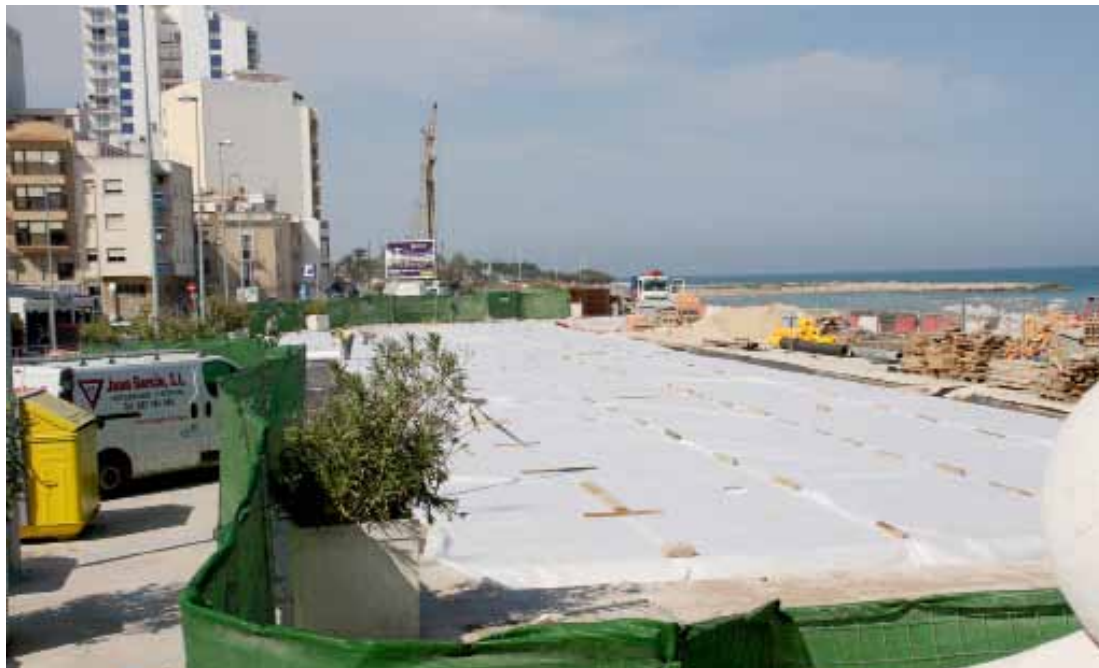
Vista de la superfície del parking soterrat del passeig marítim
