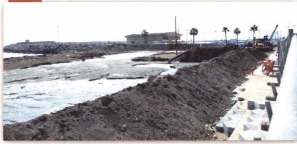
Ports fa obres de dragatge al port i aboca l'arena al Fortí
