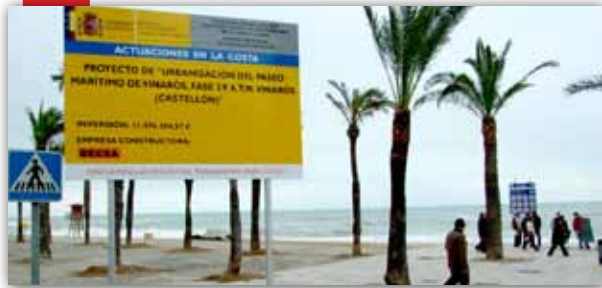
Comencen les obres de remodelació del tram final
