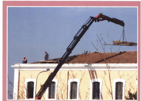
Aquesta setmana s'ha estat reparant el sostre de l'estació de tren
