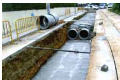
L'Ajuntament escomet les obres de canalització d'un tram de la partida dels Boverals per evitar-hi inundacions
