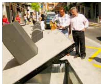
Renovació de dotacions urbanístiques al carrer dels Socors i implantació de contenidors soterrats
