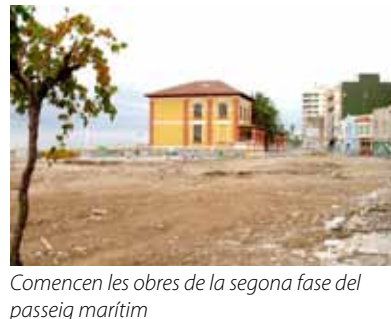
Comencen les obres de la segona fase del passeig marítim
