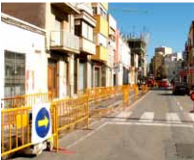
S'inicia la instal·lació de gas natural
