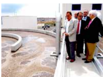
S'inaugura la depuradora
