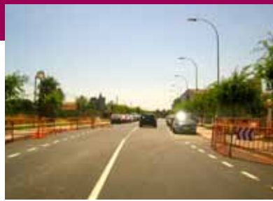
Millors al paviment de l'accés a l'hospital
