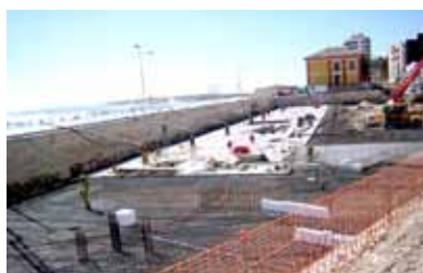
Formigonat del pàrquing soterrat del passeig marítim
