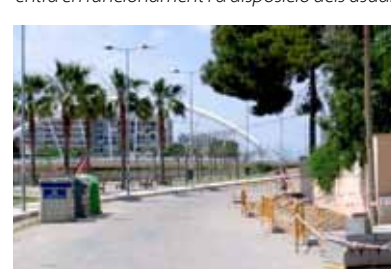
S'inicia l'últim tram de construcció de la vorera del riu Cervol, a la zona dels Boverals, i es dota de clavegueram i aigua potable
