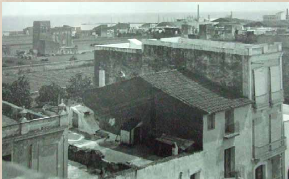
Aquesta imatge va ser presa des del carrer de Sant Francesc i apareix l'anomenada Torre Ballester amb la seua configuració originària
